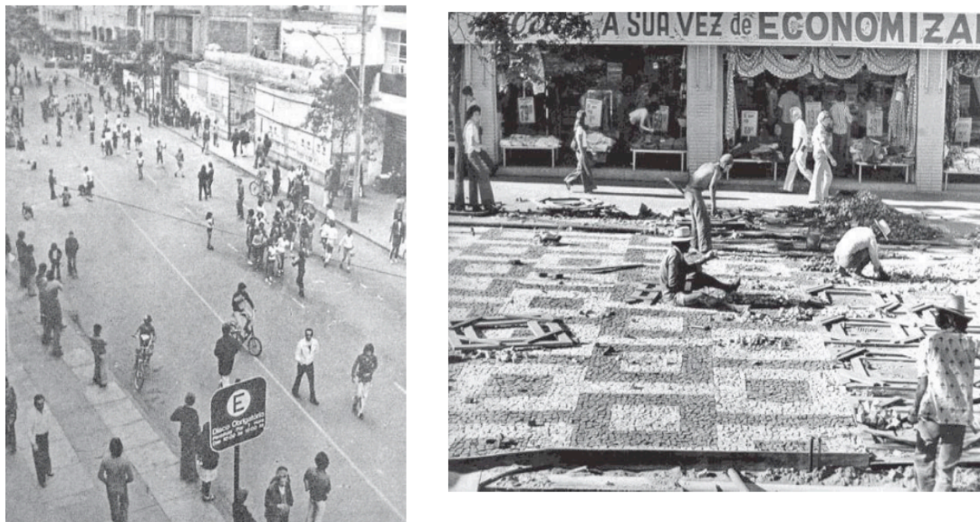
Figura 7 – Construção do calçadão de Londrina no final dos anos 1970
