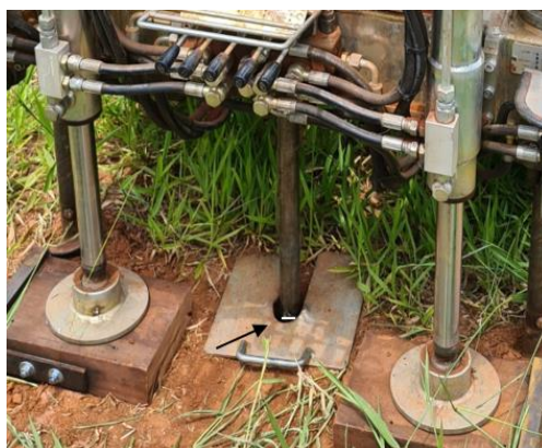
Figura 25: Marca de giz na haste de cravação. Fonte: Autoria própria.
