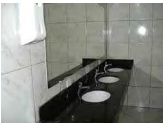
Banheiro da sede do Guarujá da ACTA-SINDGRAN
