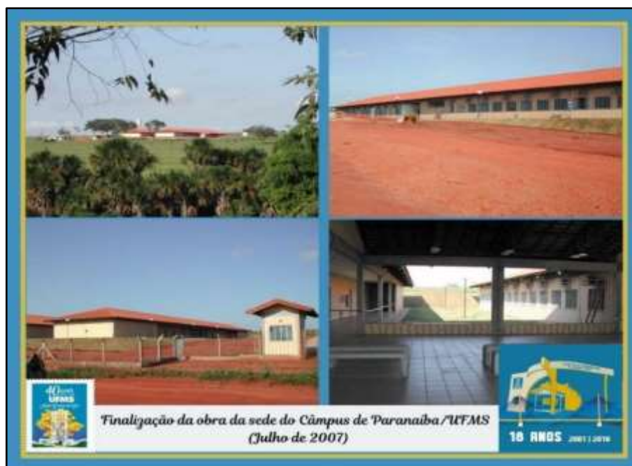
Figura 31 - Finalização da construção do câmpus da UFMS/CPAR
