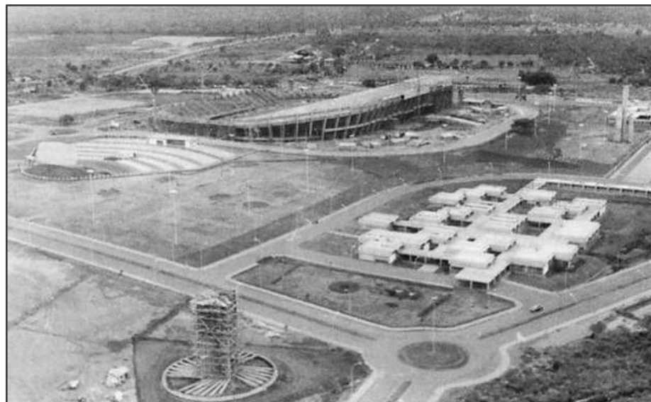
Figura 8 - Vista aérea da UEMT
