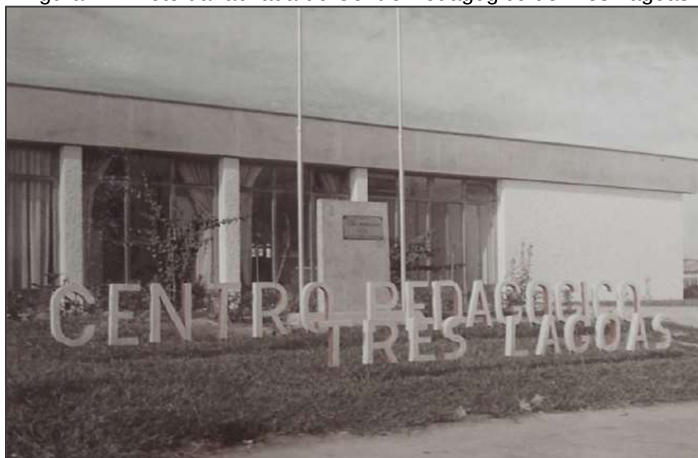
Figura 27 - Foto da fachada do Centro Pedagógico de Três Lagoas
