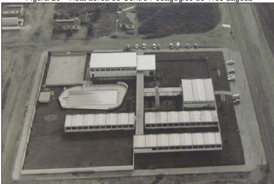
Figura 26 - Vista aérea do Centro Pedagógico de Três Lagoas
