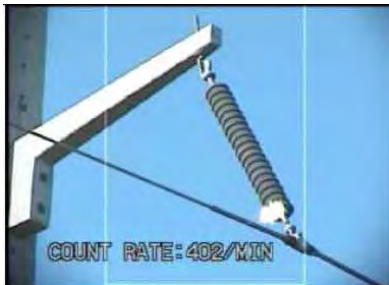
Figura 8 – Isolador Polimérico de Suspensão.
