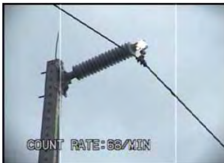
Figura 7 – Isolador Polimérico de Ancoragem.
