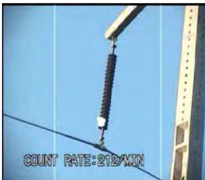
Figura 16 – Isolador Polimérico do tipo Bastão na qual é feita a contagem de número de fótons.
