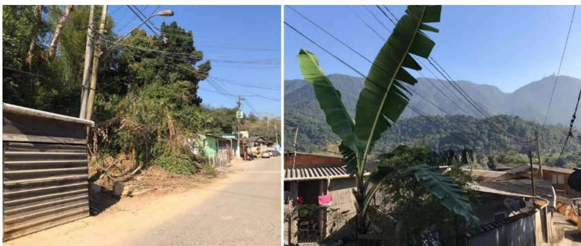
Figura 34 – Ocupações antrópicas por instalação de moradias beirando encostas no bairro dos Pilões, Cubatão 2019.
