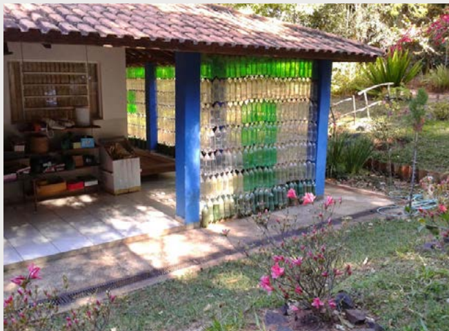
Figura 6 Parede de garrafas PET (EMA).
