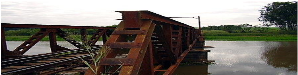
Figura 25 - Ponte sobre o rio Pardo, depois da estação de Salto Grande.
