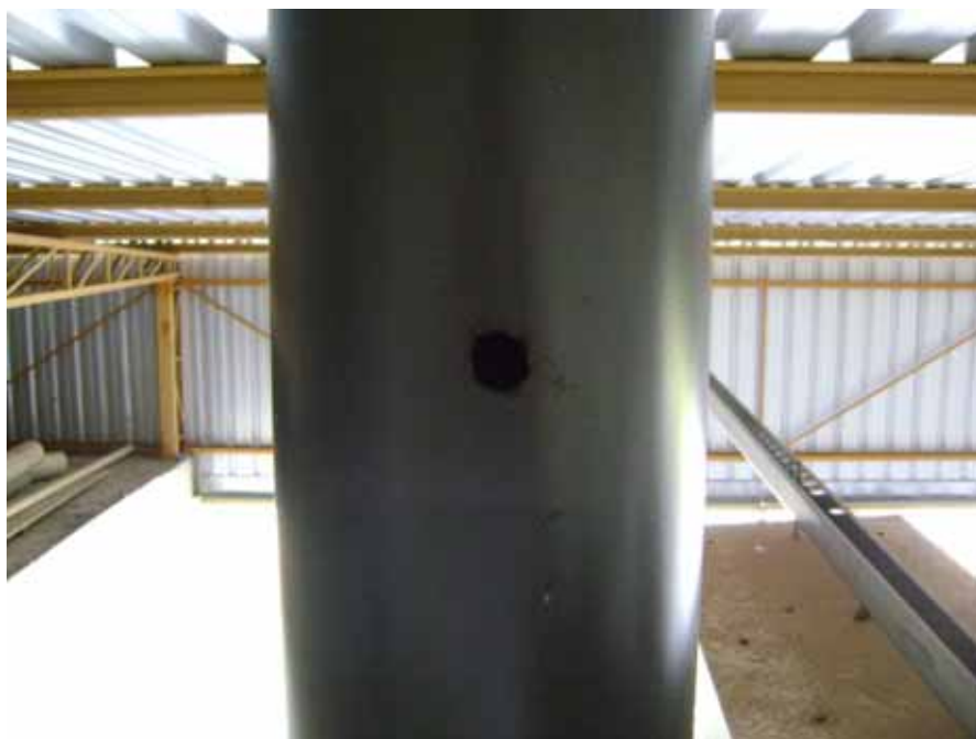
Figura 23. Orifício feito na chaminé para análise de gases
