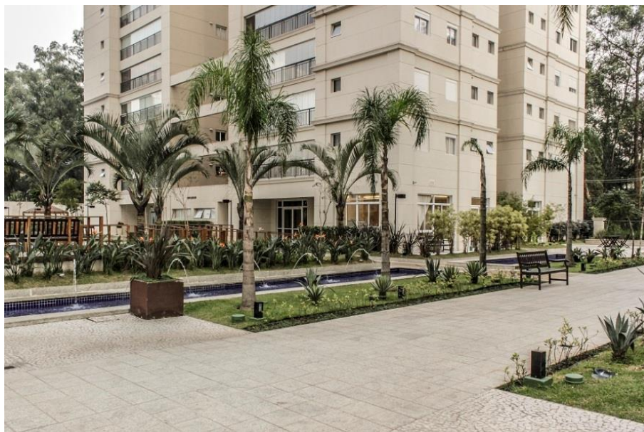
Figura 84: Vista da esplanada central.
