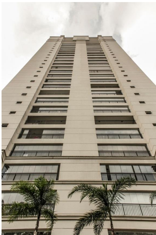
Figura 96: Vista do edifício.
