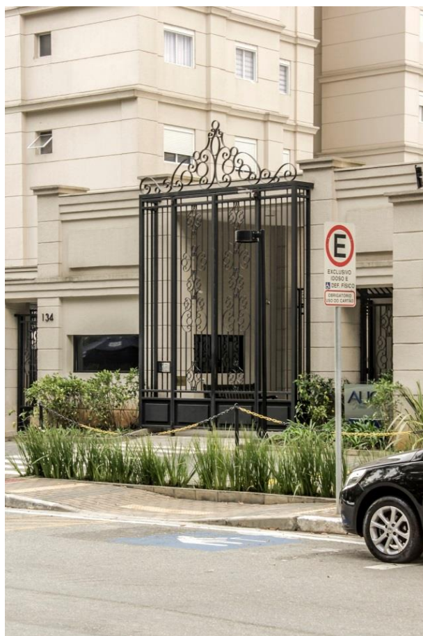
Figura 67: Portaria principal (P1). Detalhe do portão.
