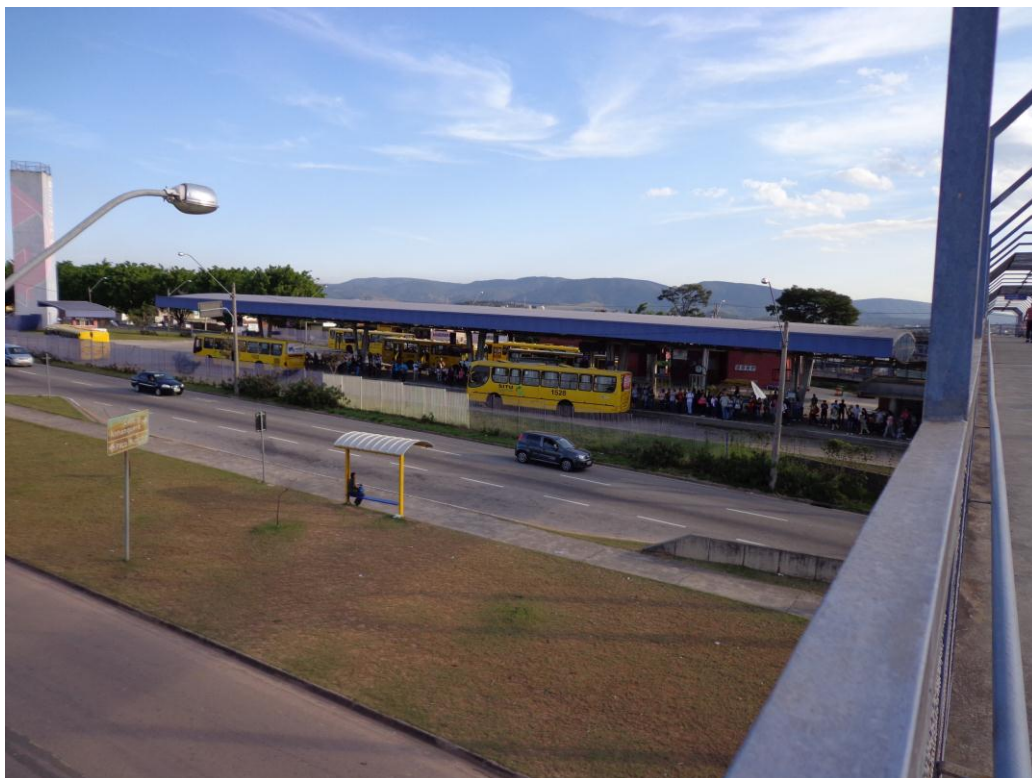
Foto Externa do Terminal Hortolândia. Fonte: Zanotello (2012)
