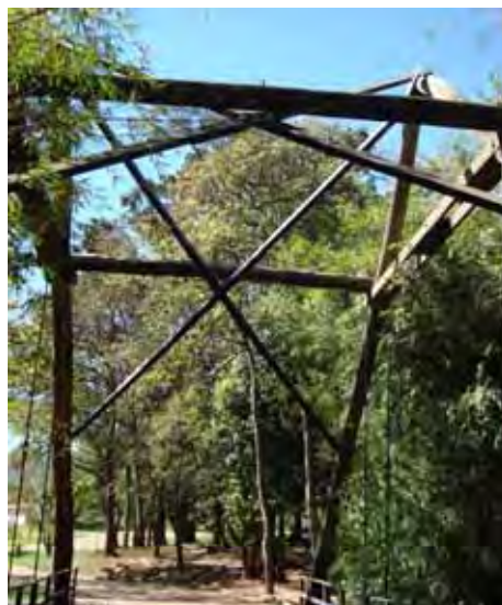
Figura 26 – Travamento na horizontal do pórtico de madeira roliça. Fonte: Galvani Engenharia
