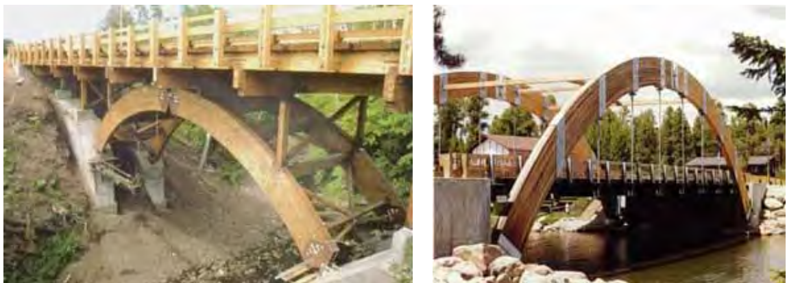
Figura 17 - Exemplo de ponte de madeira em arco. Fonte: Base De Dados Do Lamem.
