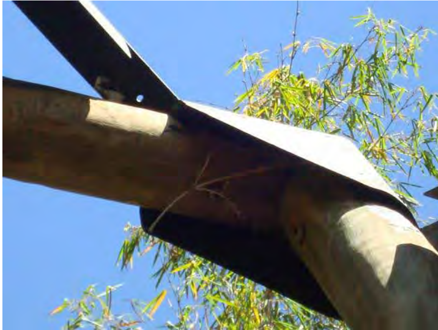
Figura 25 – Detalhe da ligação entre as peças de madeiras roliças que constituem o pórtico. Fonte: Galvani Engenharia
