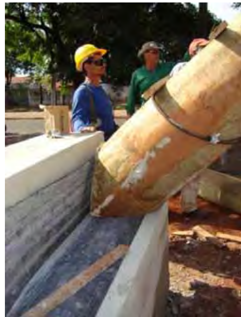
Figura 34 - Detalhe do término da base de apoio do pórtico. Fonte: Galvani Engenharia
