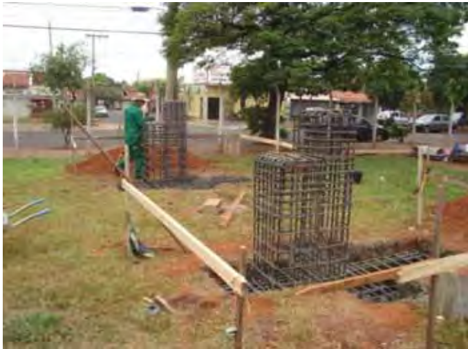
Figura 33 - Detalhe da armadura da base de apoio do pórtico. Fonte: Galvani Engenharia
