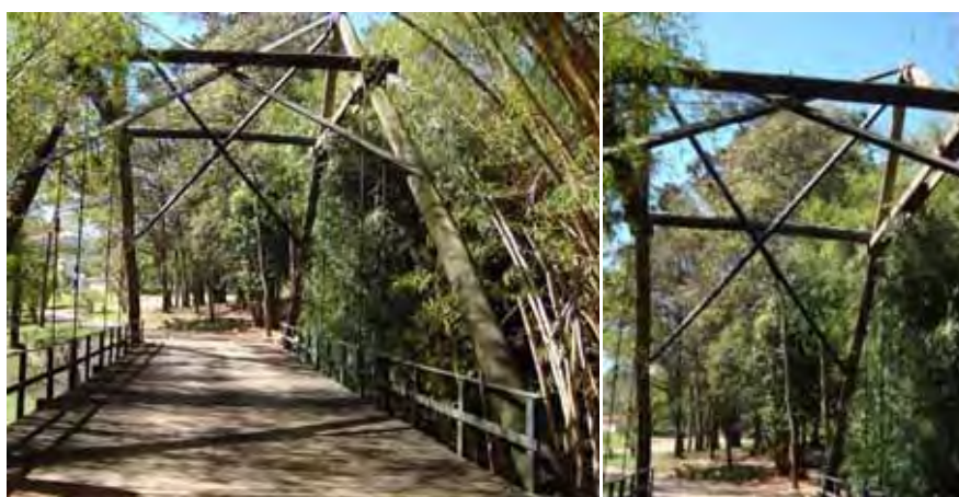
Figura 24 - Ponte construída em São João da Boa Vista SP pela Galvani Engenharia. Fonte: Galvani Engenharia
