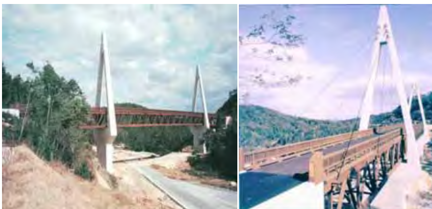
Figura 13 - Exemplo de ponte de madeira estaiada. Fonte: Base De Dados Do Lamem.
