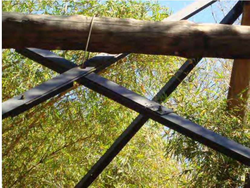
Figura 27 - Detalhe do contraventamento em "X" do pórtico. Fonte: Galvani Engenharia
