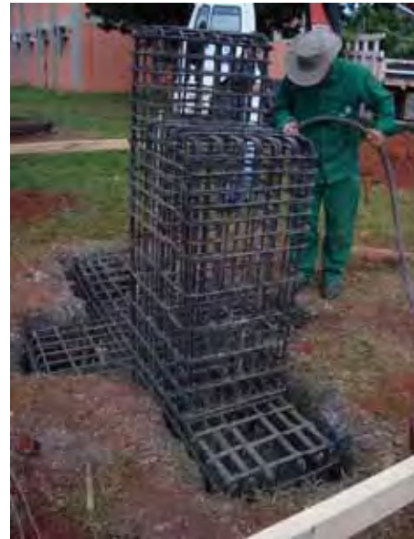
Figura 33 - Detalhe da armadura da base de apoio do pórtico. Fonte: Galvani Engenharia
