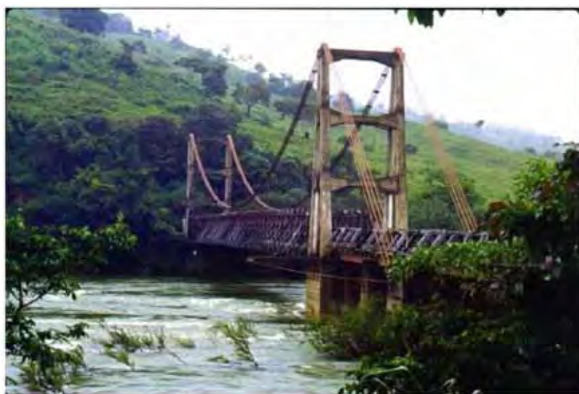
Figura 11 - Vista geral da ponte pênsil de Xavantes. Fonte: Vasconcelos (1993)
