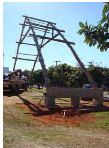
Figura 35 - Posicionamento do pórtico sobre a base de apoio. Fonte: Galvani Engenharia
