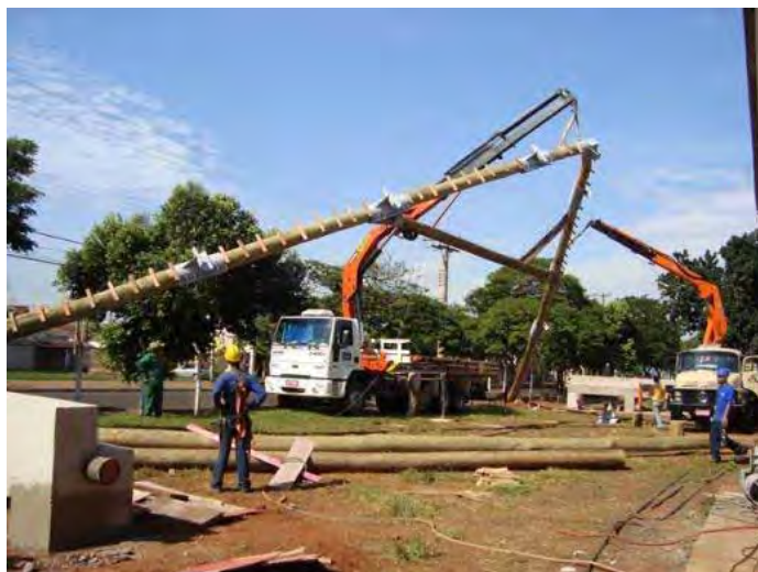
Figura 35 - Posicionamento do pórtico sobre a base de apoio. Fonte: Galvani Engenharia
