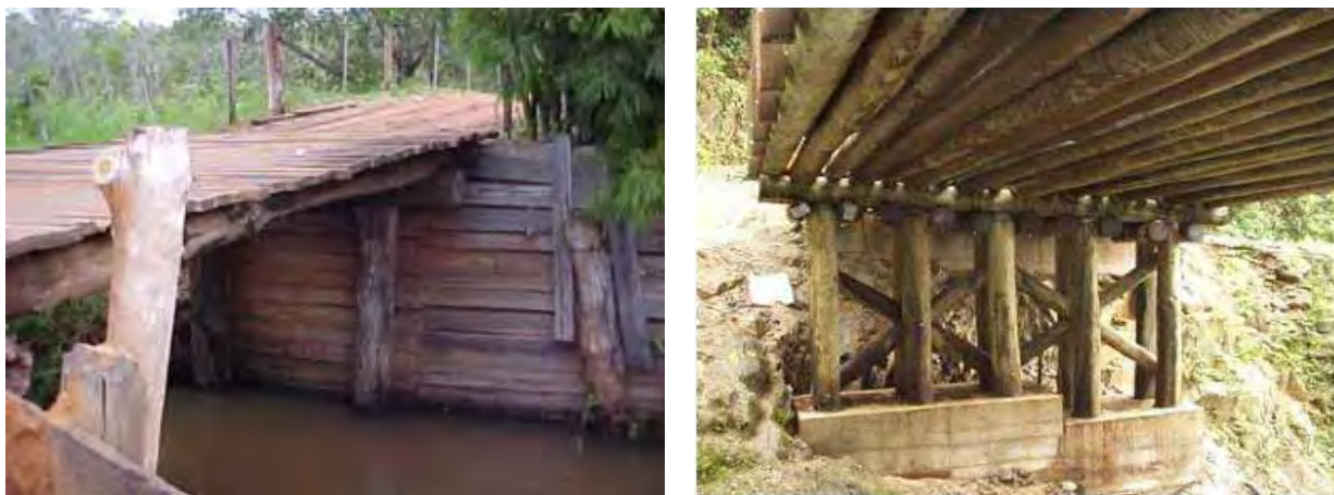
Figura 6 - Exemplo de pontes com vigas simples de peças roliças. Fonte: Base De Dados Do Lamem.
