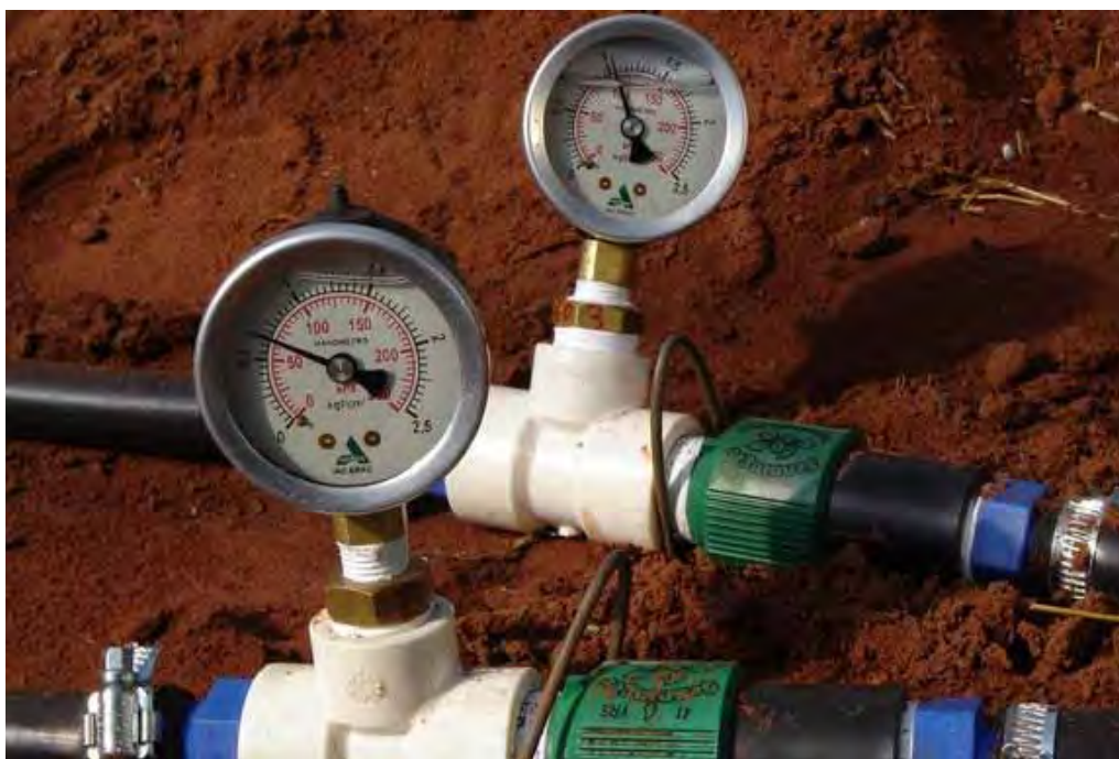
Figura 7. Válvulas reguladoras de pressão de 70 e 100 kPa e manômetros de controle, instalados nas linhas principais de irrigação.
