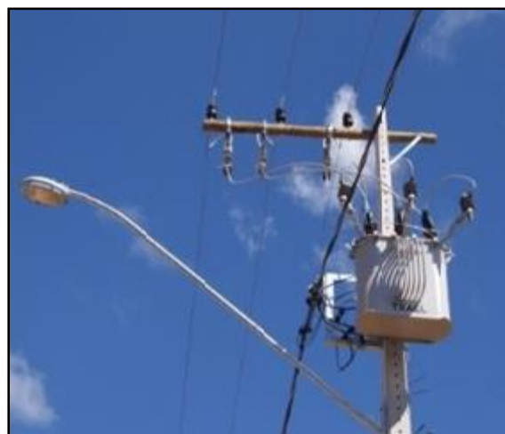
Figura 2: Esquema trifásico (urbana)
