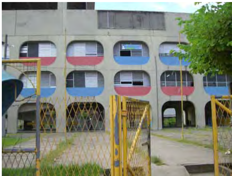
Figura 05: Fachada do polo de Itaperuna Fonte: A autora
