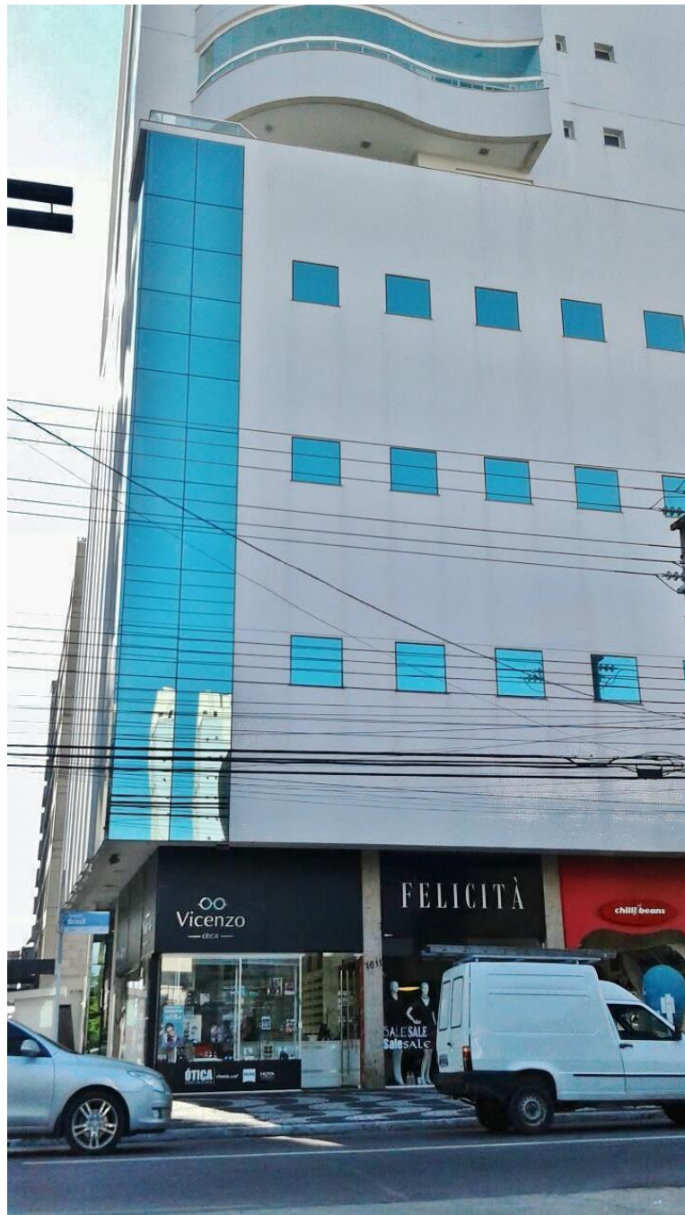
Foto 4: Comércio e edifícios residenciais ocupam o mesmo espaço.
