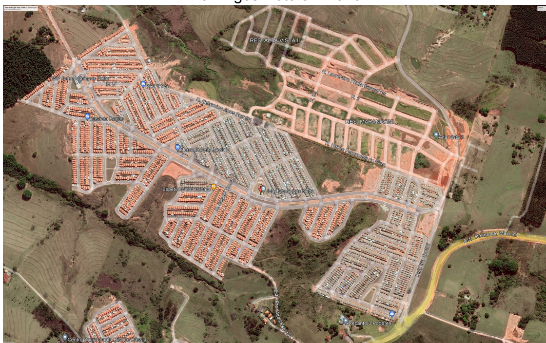
Figura 10. Área durante a construção do Conjunto Habitacional João Domingos Neto em 2016.
