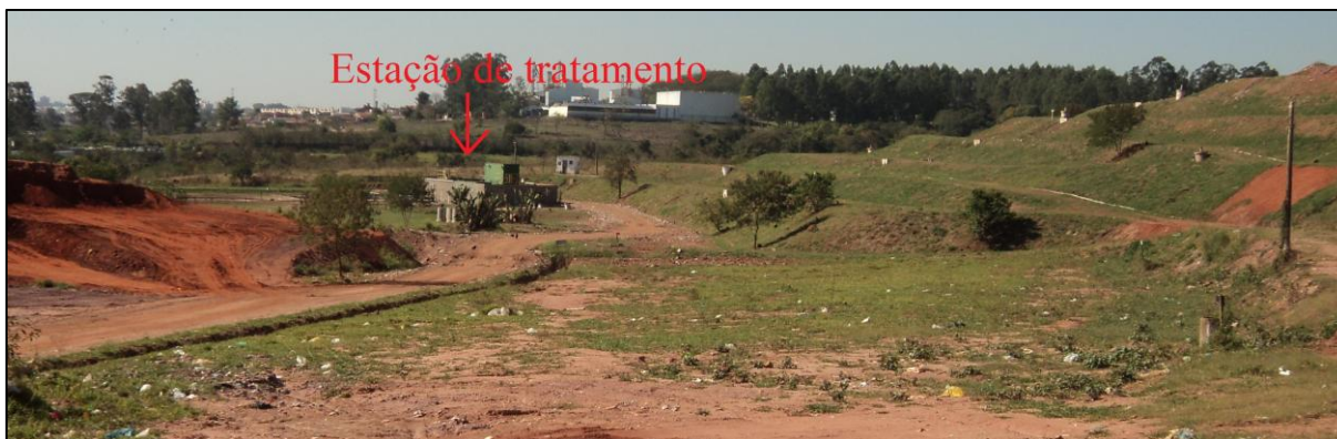
Figura 11– Estação de Tratamento de Percolado - Visão geral no Aterro Sanitário
