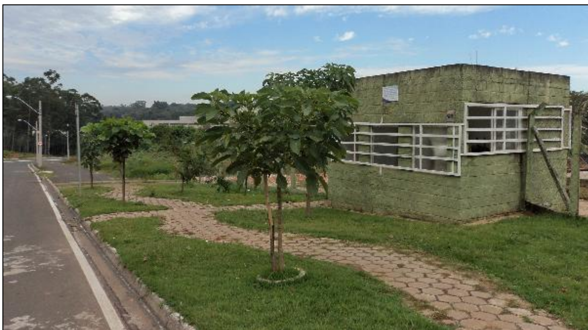
Figura 24 – Entrada Ecoponto São Miguel
