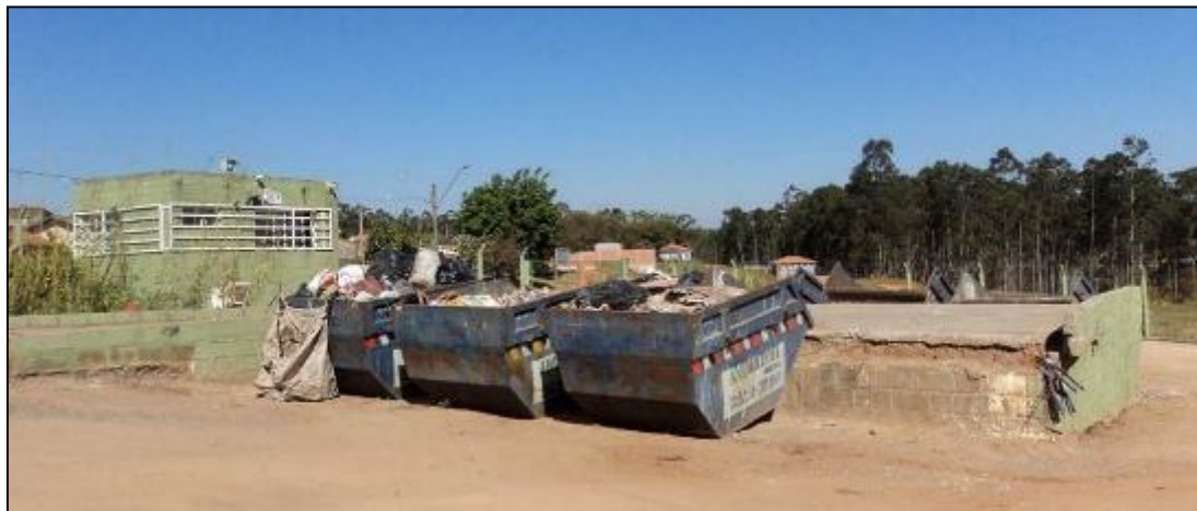
Figura 25 - Área interna com caçambas para resíduos volumosos no Ecoponto São Miguel
