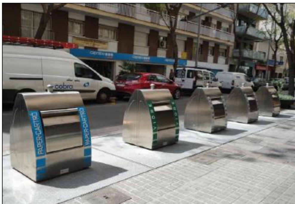
Figura 14 - Contêineres com armazenamento subterrâneo de resíduos na cidade de Cerdanyola del Valles – Província de Barcelona
