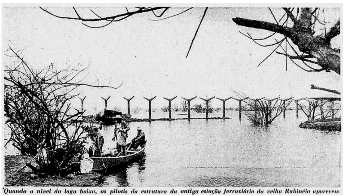
Figura 6: Fotografia da manchete “Represa tira duas cidades do mapa” e, ao fundo, a estrutura da cobertura da Estação Presidente Vargas sendo submersa.
