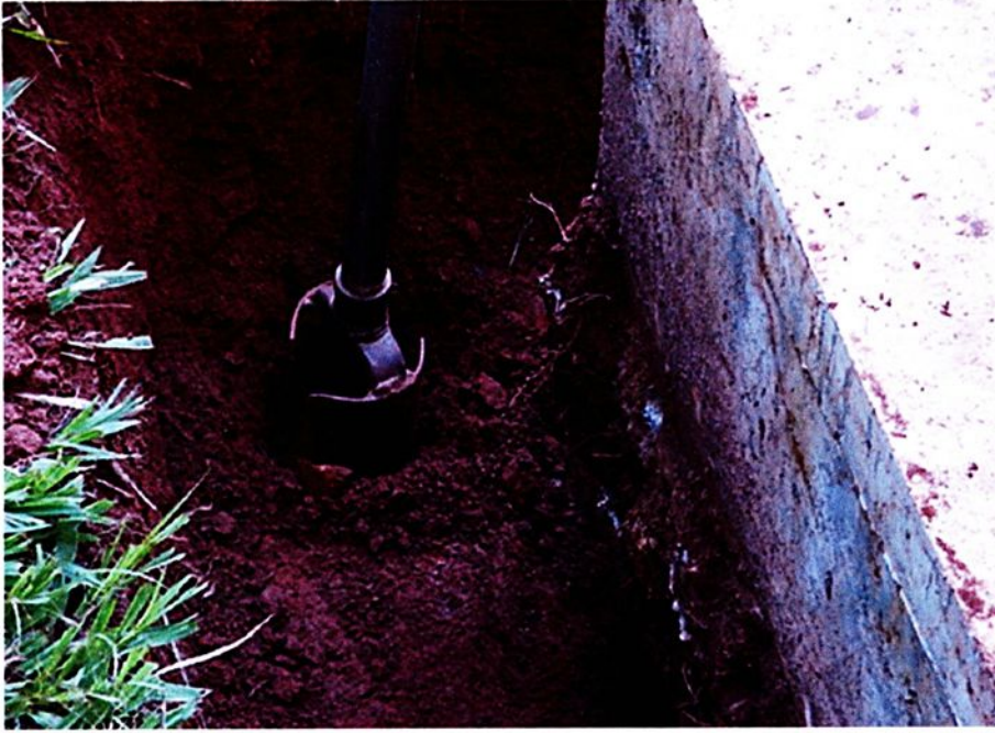
Foto 4.9. Execução de dreno com trado manual.
