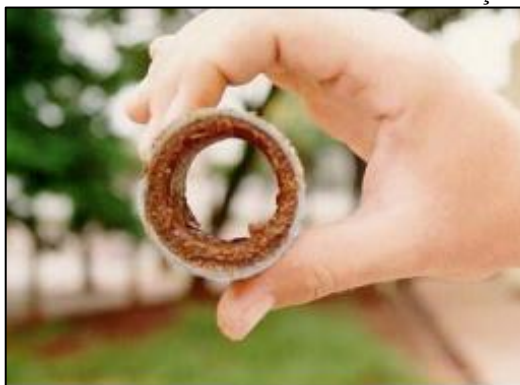
Figura 31 – Encrostamento de ferro no interior da tubulação de irrigação.
