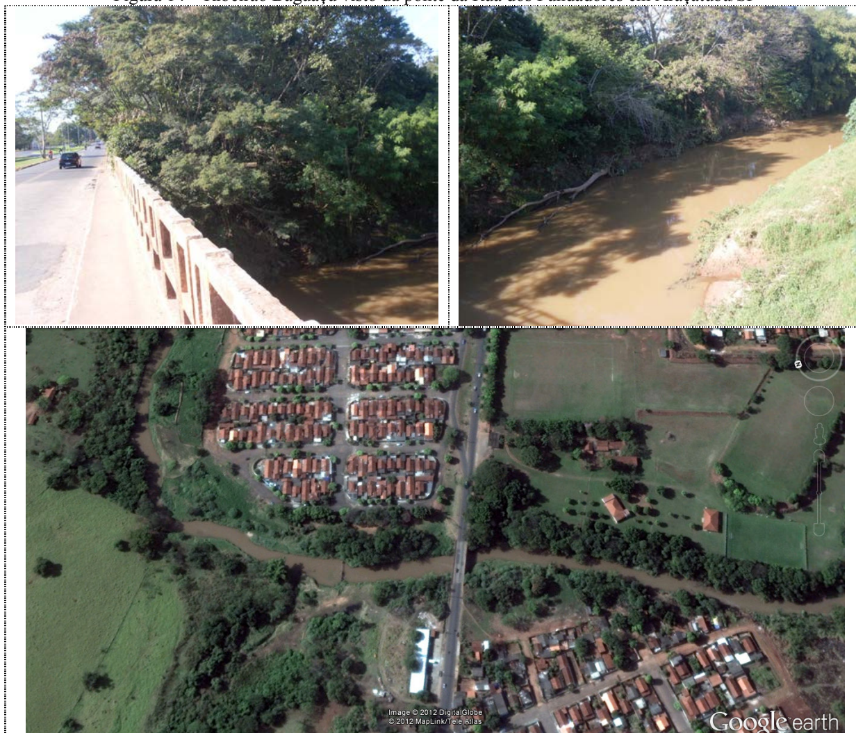
Figura 14 – Ribeirão Baguaçu visto da ponte da Rua dos Fundadores em Araçatuba/SP
