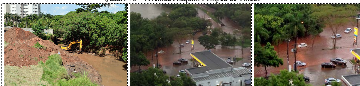
Quadro 75 – Avenida Joaquim Pompeu de Toledo
