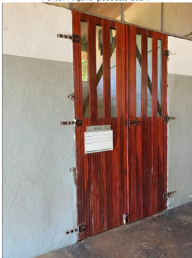
Figura 13. Dependências do Hospital Veterinário (HVGLN) 4 . Baia de isolamento.
