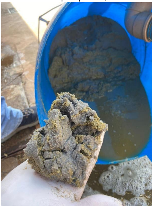
Figura 22. Conteúdo retirado, com aspecto argiloso, com coloração acinzentada.
