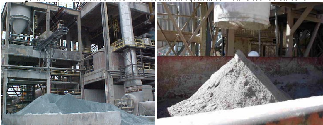
Figura 3 – Cinza de caldeira com combustão adequada, com baixo teor de carbono.
