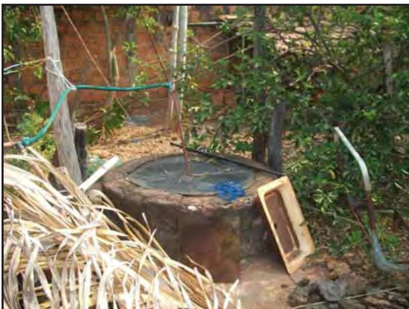
Figura 59 - Poço 6, com precária proteção e condições do entorno, localizado no setor Vila Flor. Fotografia: Ayach, L.R, agosto/2010
