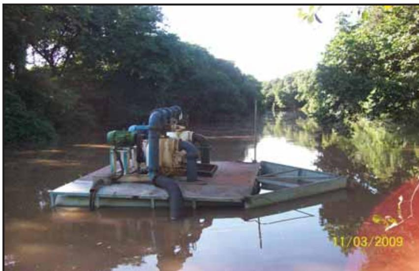
Figura 10 – Ponto de captação de água no rio Taquaruçu, para abastecimento público pela empresa SANESUL, na proximidade da foz com o rio Aquidauana. Fotografia: Lucy Ribeiro Ayach, março/2009.
