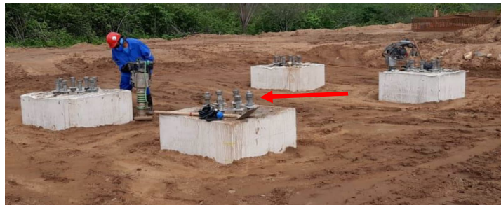
Figura 88 – Chumbadores concretados junto à fundação de pórtico 500kV
