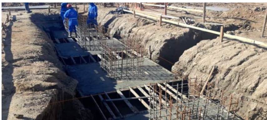
Figura 74 – Execução da fundação para parede corta-fogo pré-moldada
