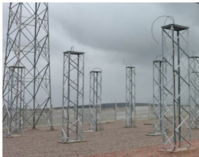
Figura 43 – Estruturas suportes para Chave Seccionadora 500 kV montadas em campo
