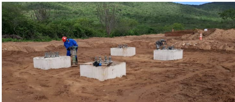
Figura 69 – Reaterro de Fundação de Pórtico 500kV concluído
