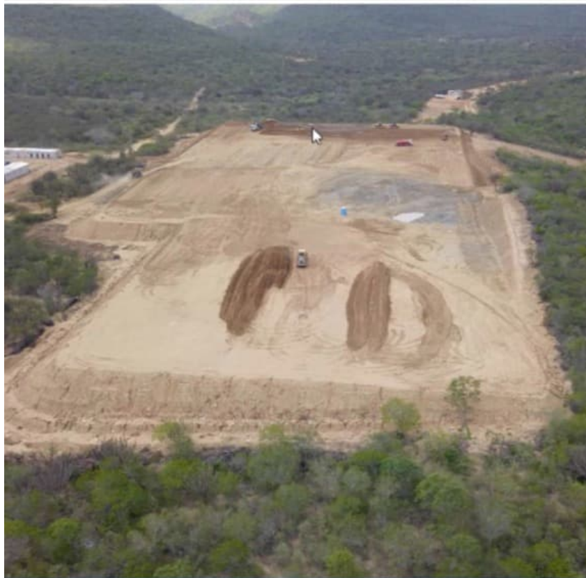
Figura 60 – Platô concluído e liberado para demais atividades
