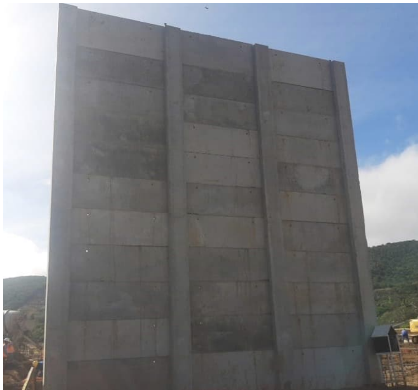
Figura 77 – Parede corta-fogo concluída
