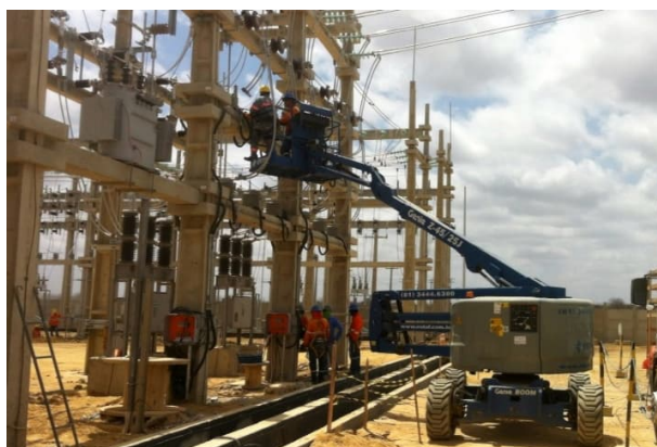
Figura 98 – Montagem de equipamentos do pátio de 34,5kV
