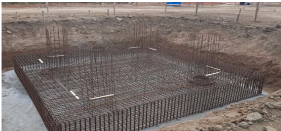
Figura 65 – Instalação de armação de Fundação de Pórtico 500kV concluída
