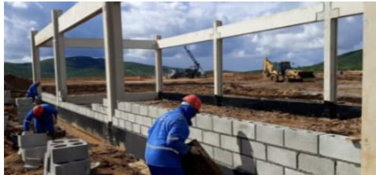
Figura 81 – Execução de fechamento em alvenaria da Casa de Comando
