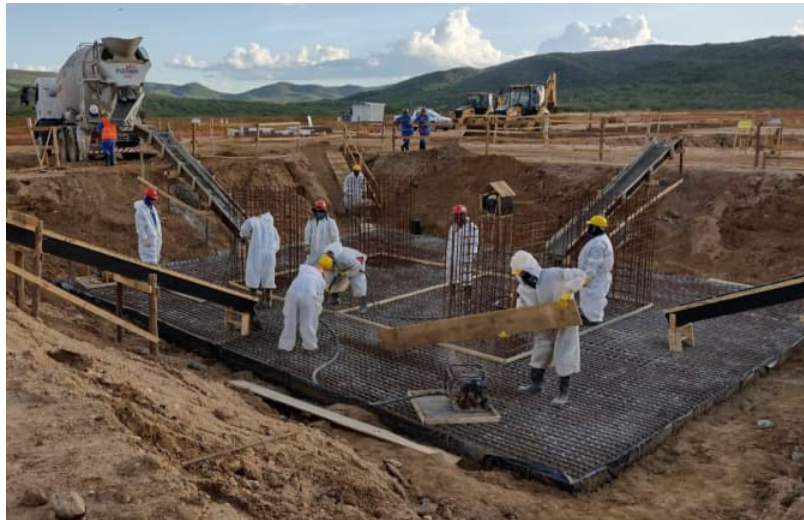
Figura 67 – Concretagem de Fundação de Pórtico 500kV em andamento
