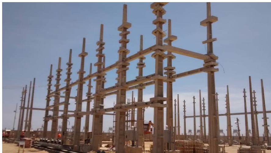
Figura 92 – Pórtico 34,5kV em concreto com montagem em fase final
