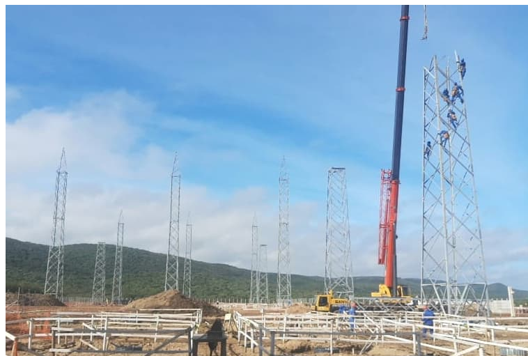
Figura 90 – Içamento, verticalização e montagem de trecho metálico de pórtico 500 kV
