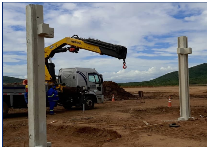
Figura 79 – Instalação de pilares pré-moldados da Casa de Comando
