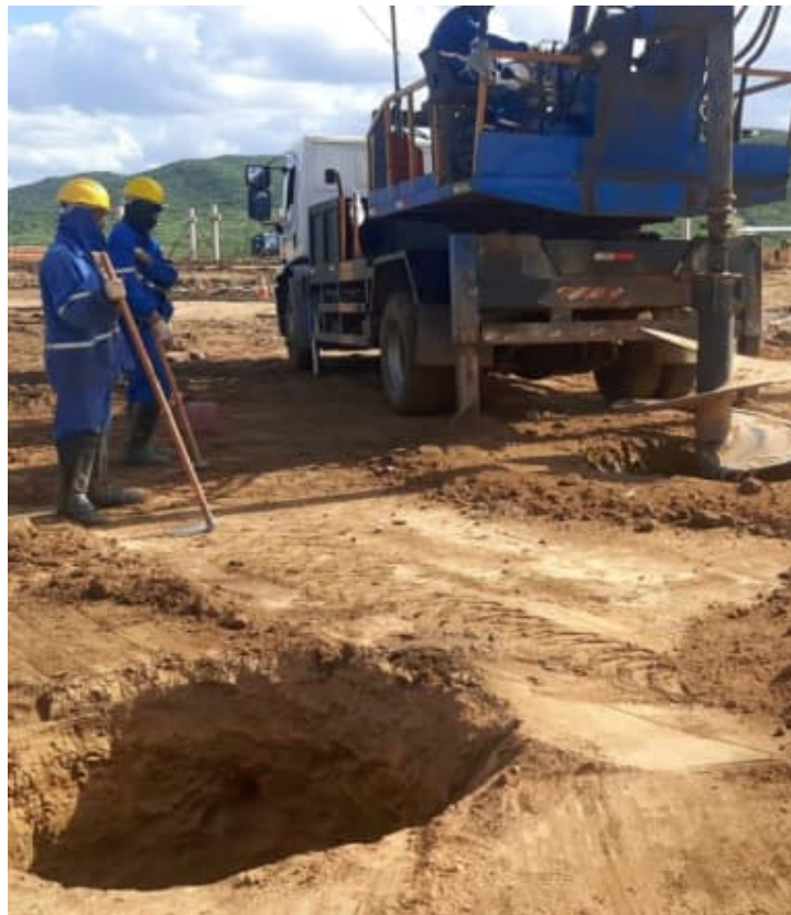
Figura 70 – Escavação de tubulão a partir de perfuratriz para fundação de pórtico de 34,5kV
