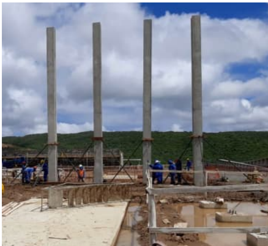
Figura 75 – Instalação dos pilares pré-moldados
