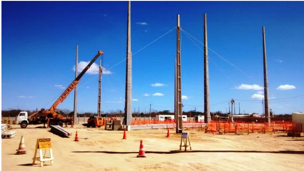
Figura 91 – Içamento, verticalização e fixação de pórtico 34,5 kV
