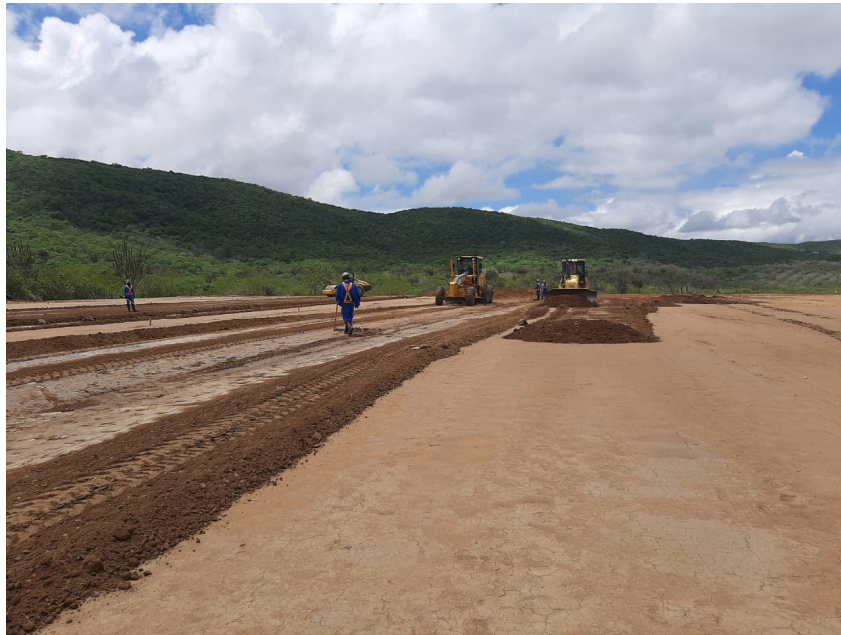
Figura 59 – Execução de aterro
