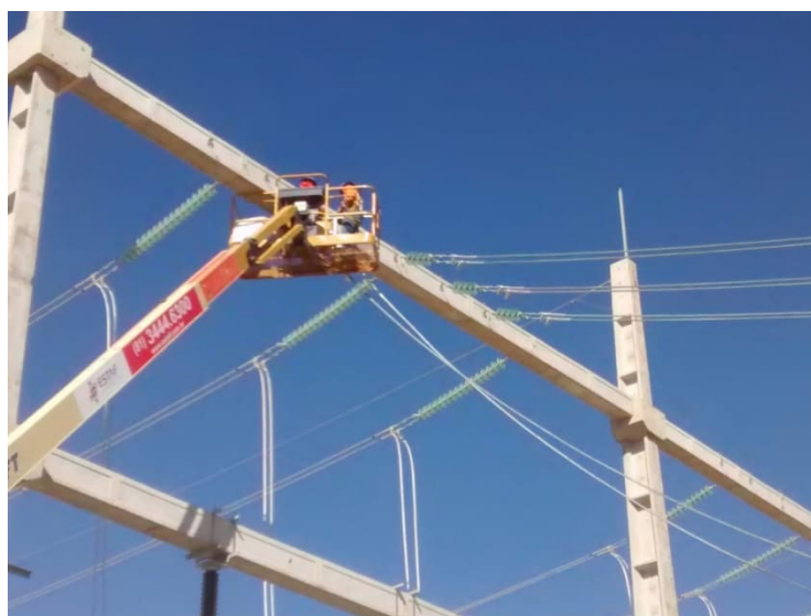
Figura 94 – Montagem de barramento do setor de 34,5kV
