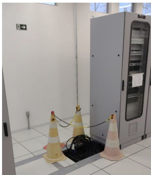
Figura 99 – Base metálica aguardando fixação de painel na casa de comando
