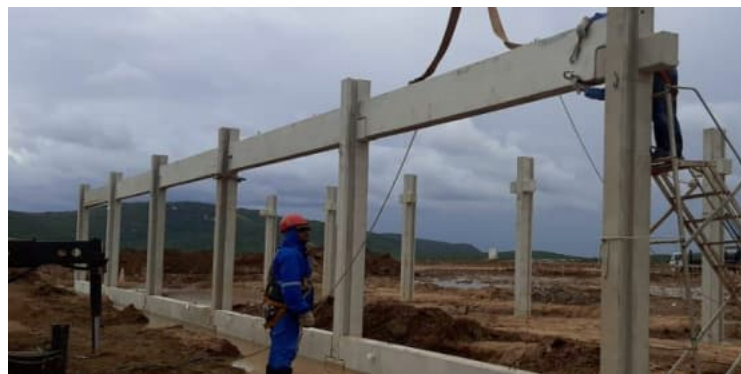
Figura 80 – Instalação de vigas pré-moldadas da Casa de Comando
