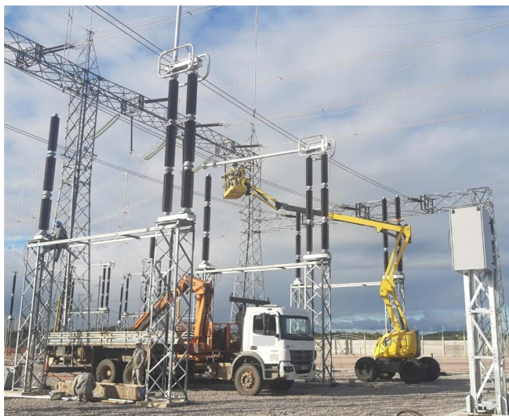
Figura 96 – Montagem de Seccionadora 500kV
