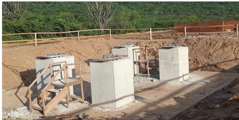
Figura 68 – Desforma de fustes de Fundação de Pórtico 500kV Concluída
