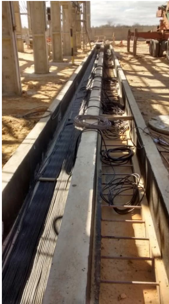
Figura 85 – Canaletas concluídas e em recebimento de cabos de baixa tensão
