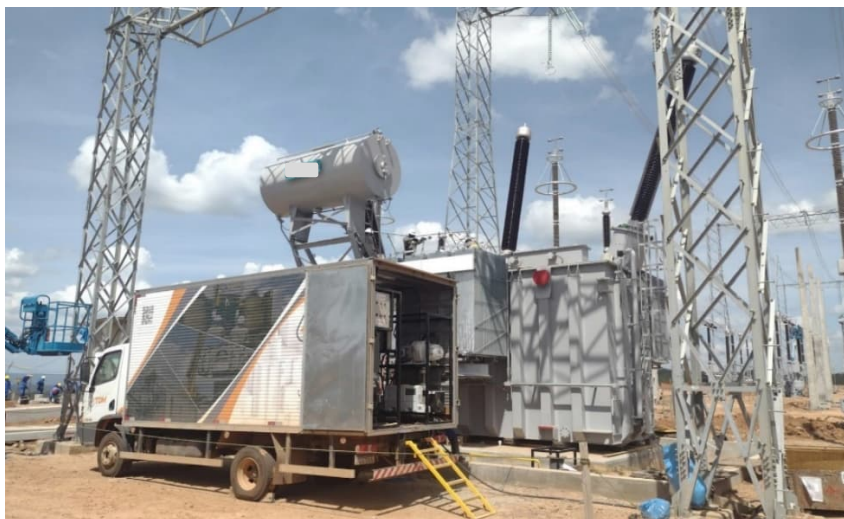
Figura 95 – Montagem de Transformador 34,5/500 kV
