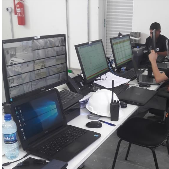
Figura 107 – Comissionamento de painéis a partir do sistema supervisório
