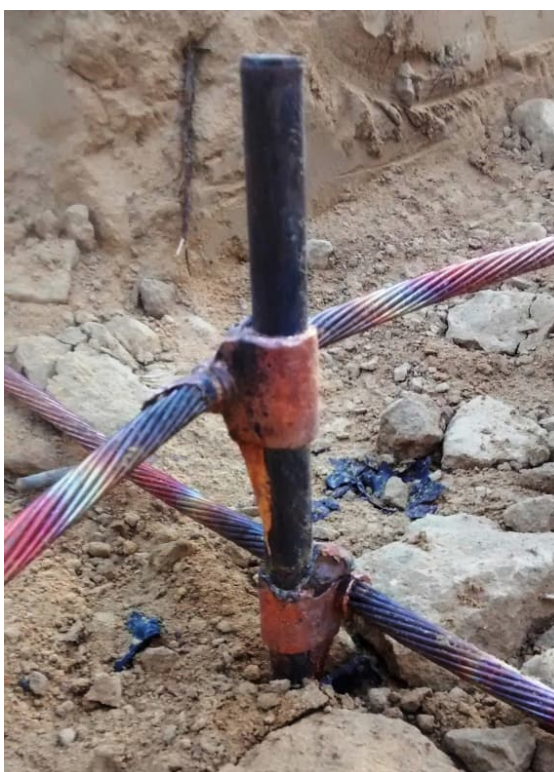
Figura 102 – Solda exotérmica concluída
