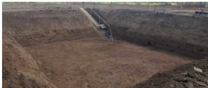
Figura 63 – Escavação de Fundação de Pórtico 500kV concluída
