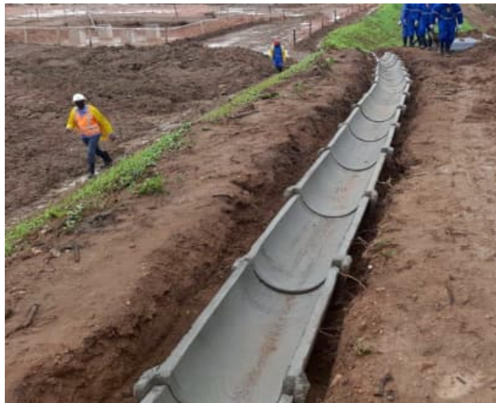
Figura 73 – Meia-cana dos taludes
