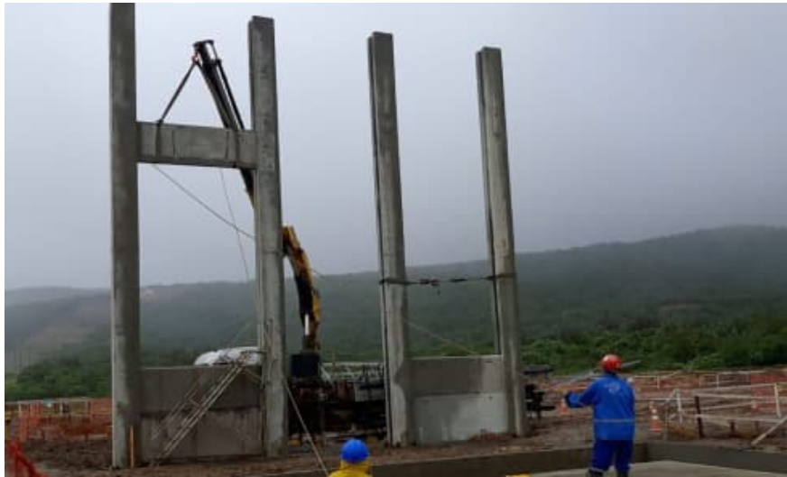
Figura 76 – Içamento e encaixe das placas pré-moldadas
