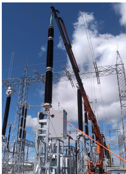
Figura 97 – Montagem de Disjuntor 500kV
