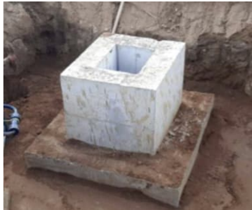
Figura 78 – Fundação da Casa de Comando
