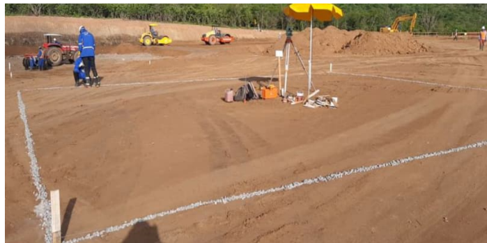
Figura 62 – Locação de Fundação de Pórtico 500kV concluída
