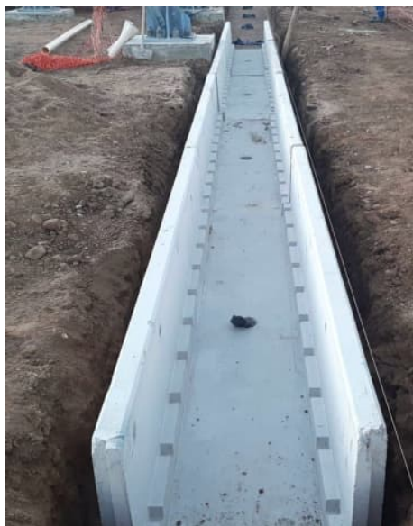
Figura 84 – Peças pré-moldadas para canaletas instaladas
