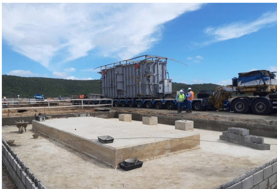
Figura 61 – Execução de bacia de captação de óleo e base para Transformador 34,5/500 kV
