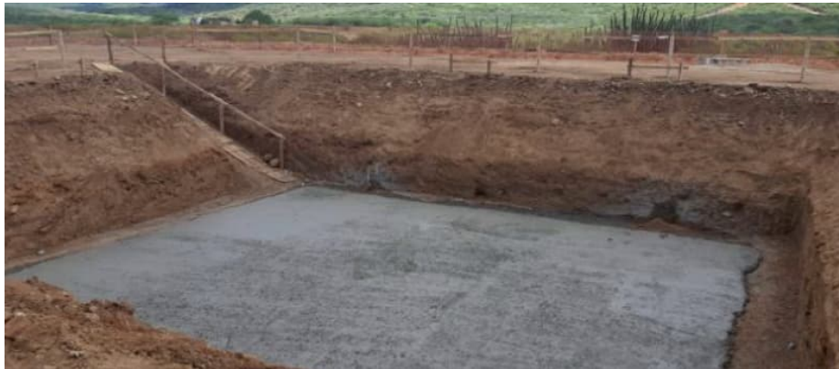
Figura 64 – Regularização de fundo de cava de Fundação de Pórtico 500kV concluído
