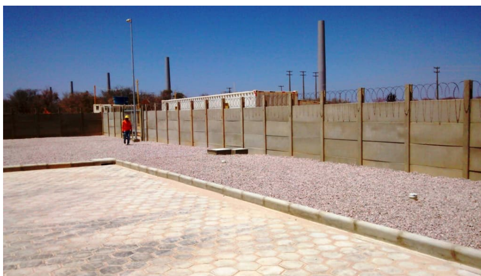
Figura 87 – Arruamento e britagem da subestação concluídos
