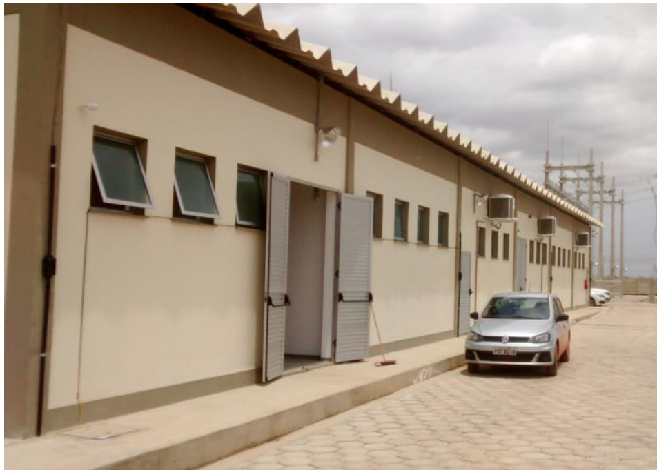
Figura 82 – Casa de Comando concluída
