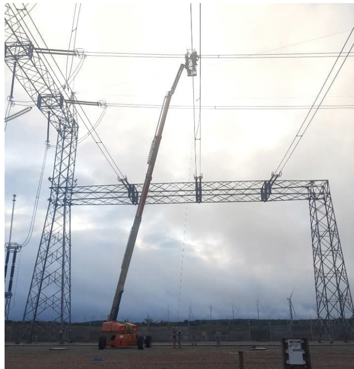
Figura 93 – Montagem de barramento do setor 500kV
