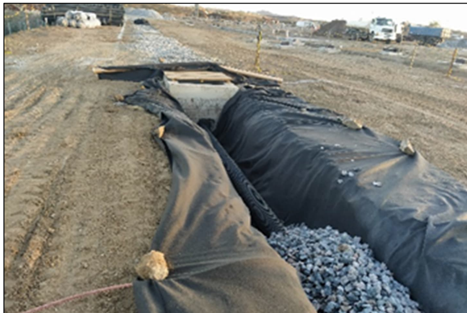
Figura 71 – Drenagem de águas pluviais em execução
