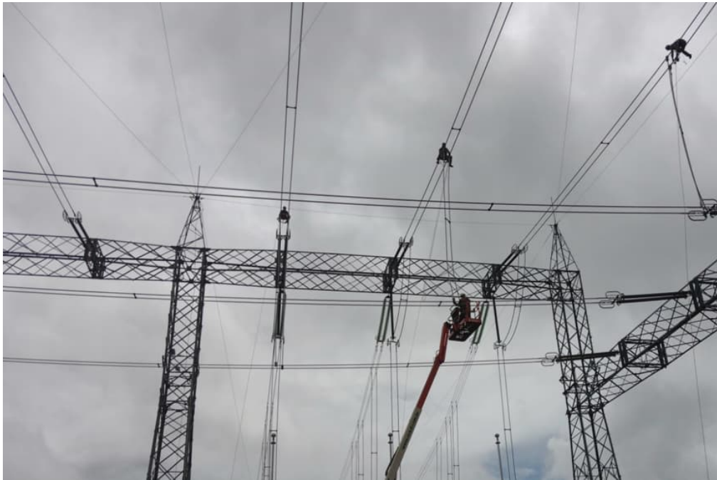
Figura 45 – Cabo de alumínio em instalação em subestação para parque eólico
