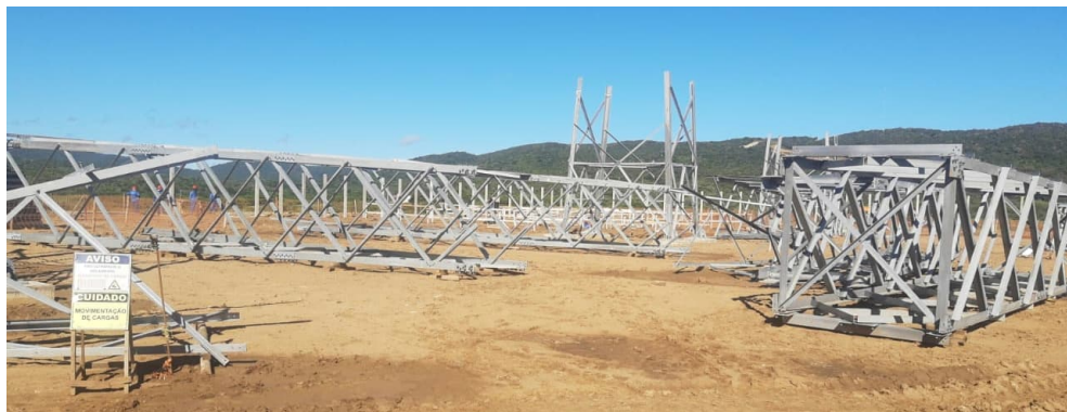
Figura 89 – Pré-montagem de pórtico metálico para setor de 500kV
