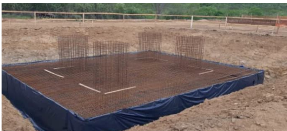
Figura 66 – Instalação de forma da base de Fundação de Pórtico 500kV aguardando escoramento
