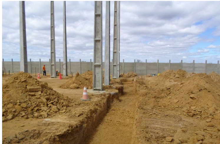
Figura 83 – Escavação para instalação de canaletas
