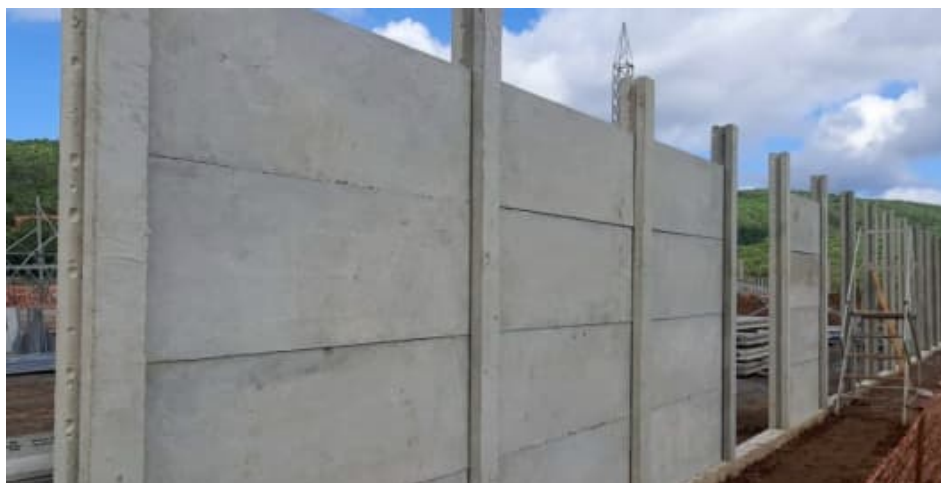
Figura 86 – Muro de fechamento em execução
