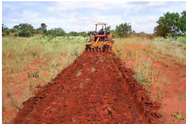
Figura 9. Preparo da área (gradagem).
