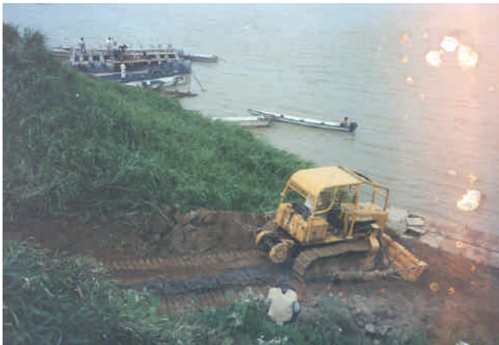
Foto 12 – Retirada da cobertura vegetal e do solo por trator, para a preparação da área para a lavra por desmonte hidráulico, no garimpo do Araras (RO) (1990).
