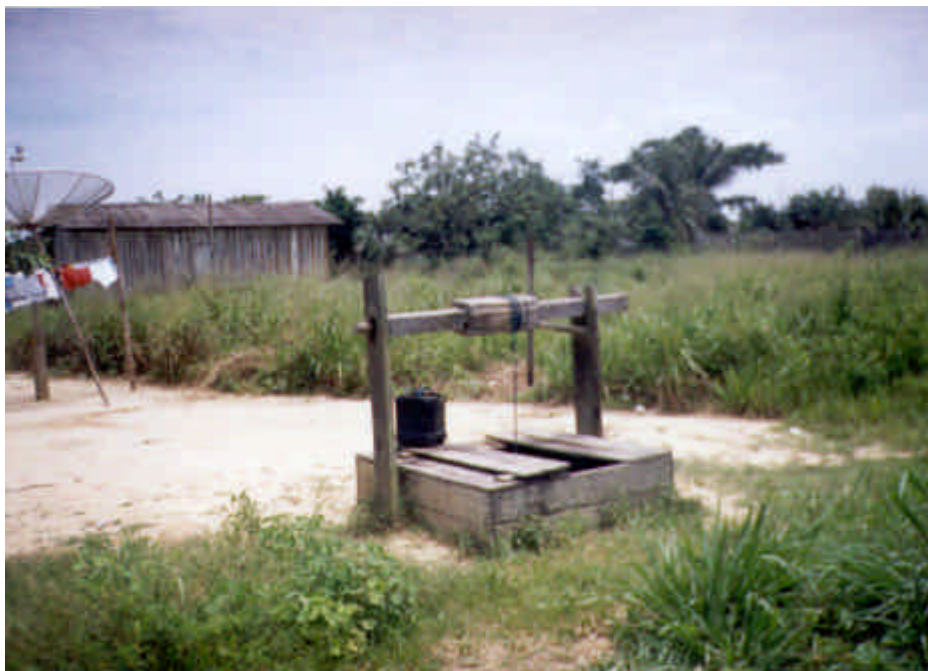
Foto 21 – Vista de um poço tipo cacimba no quintal de uma casa na Vila do Araras (RO).
