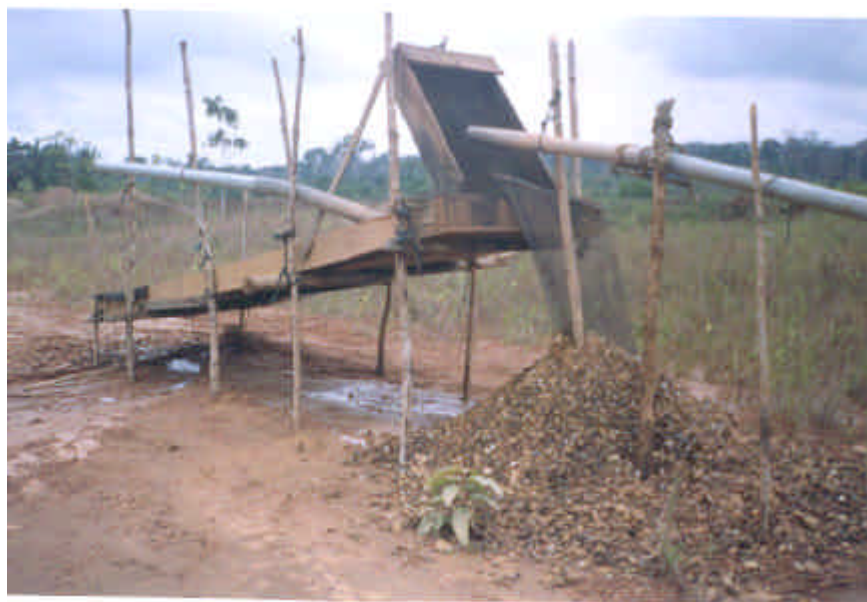
Foto 13 – Caixa de concentração para beneficiamento de cascalho aurífero. Lavra atual nas proximidades da vila do Araras, RO.
