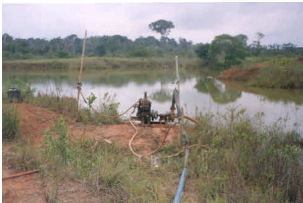
Foto 15 – Captação de água em lagoa para desmonte hidráulico. Lavra atual próxima a Vila do Araras, Nova Mamoré, RO.
