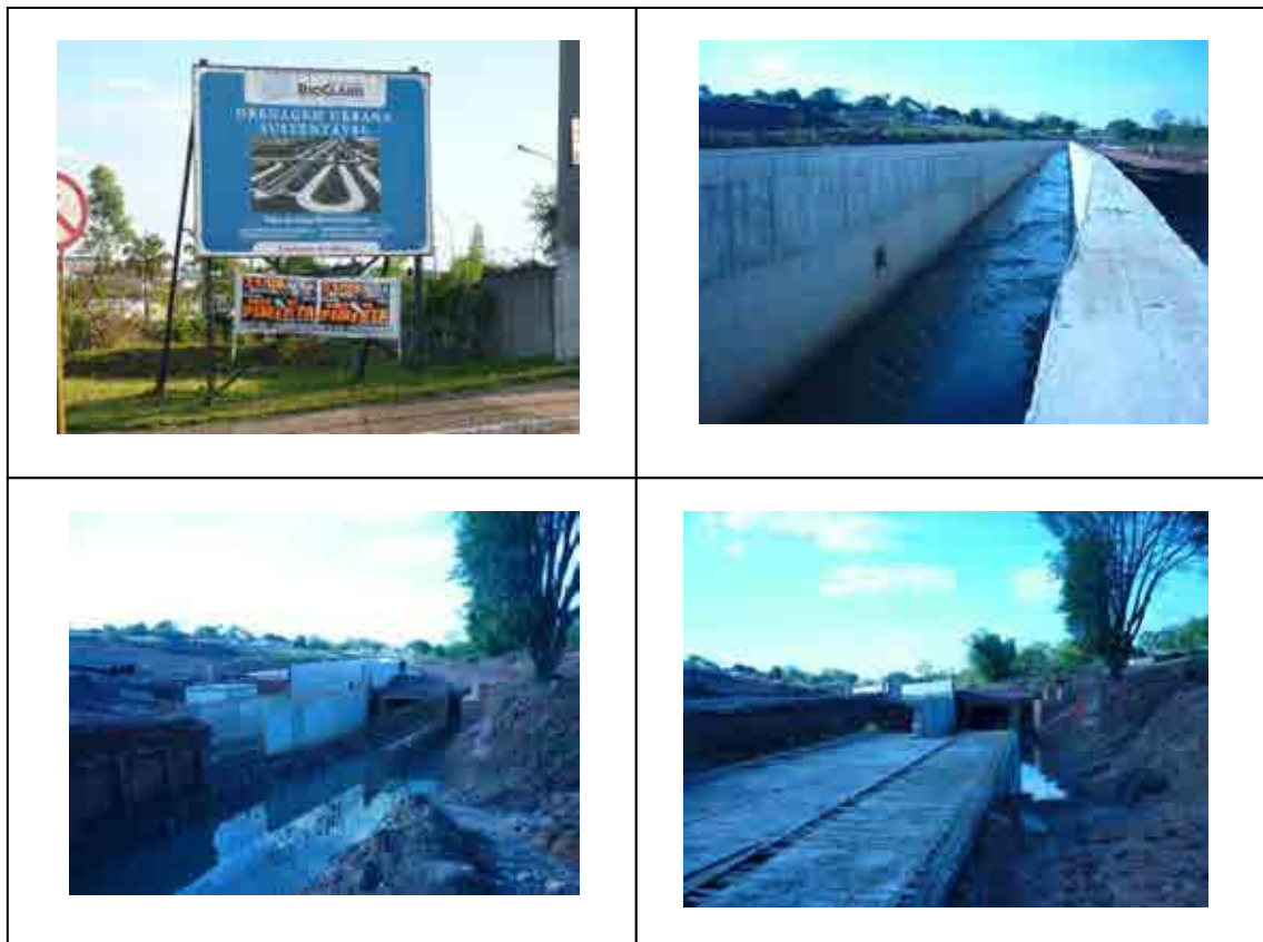
Imagem 17: Obras de drenagem no Jardim Inocoop.
