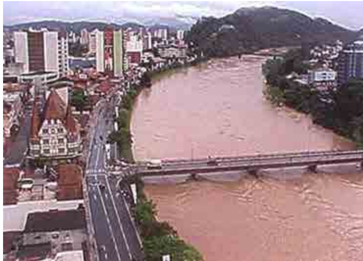
Imagem 12: Situação de enchente em um canal de drenagem (Ministério das Cidades/IPT 2007, p.90).
