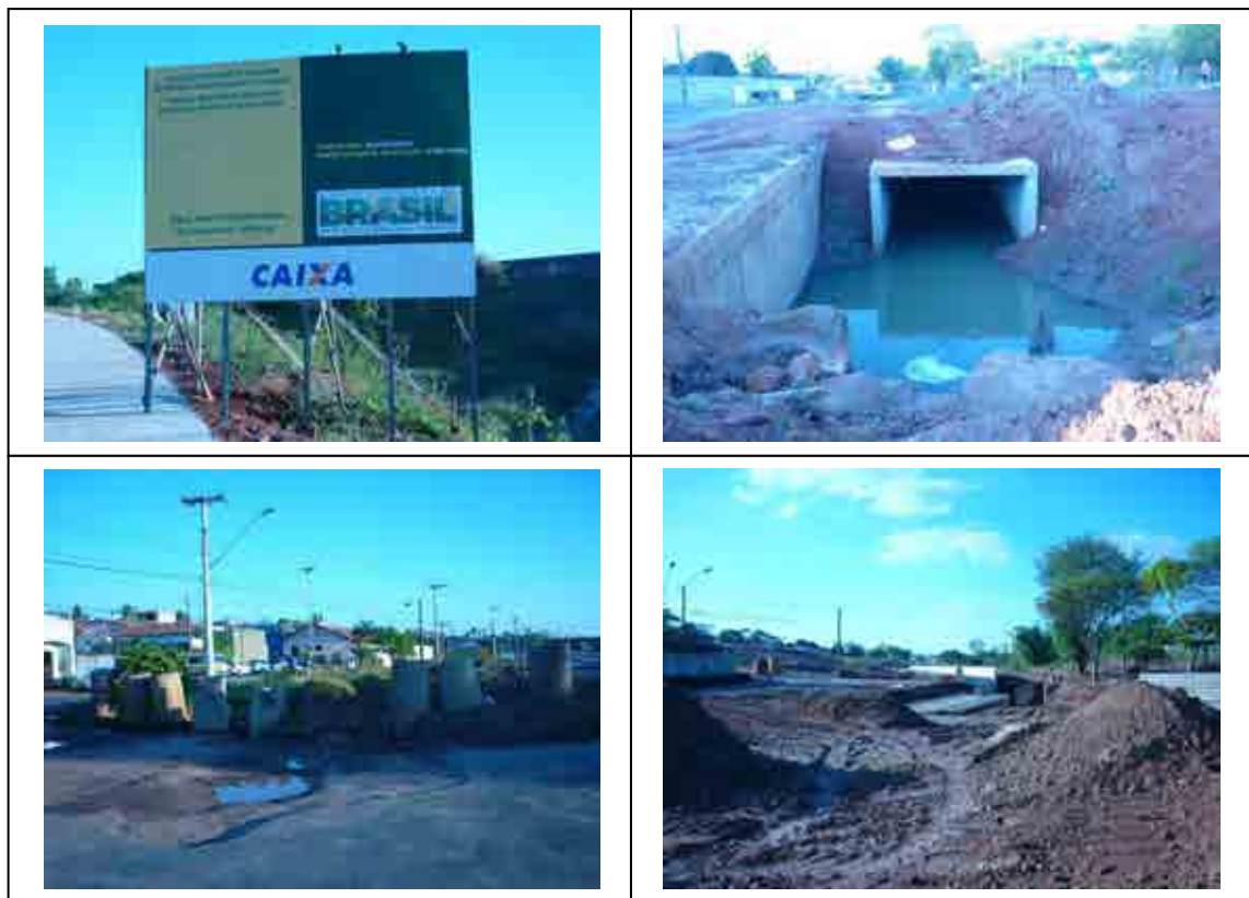
Imagem 9: Obras de contenção de enchentes no Jardim Inocoop.
