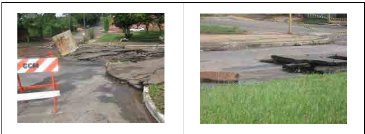
Imagem 8: Placas do pavimento arrastadas pela força d'água. Acervo pessoal da moradora Denise Oliveira.
