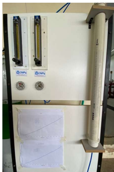
Figura 18 – Painel de controle e mistura de gases.
