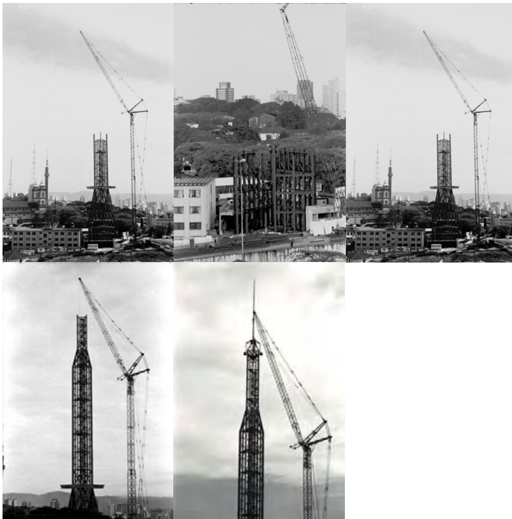
Figura 16 a 20. Edificação da torre com colocação da antena.
