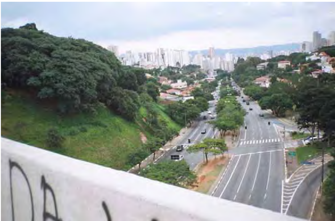
Fig. 54. Vista do Viaduto Dr. Arnaldo para Av. Sumaré.
