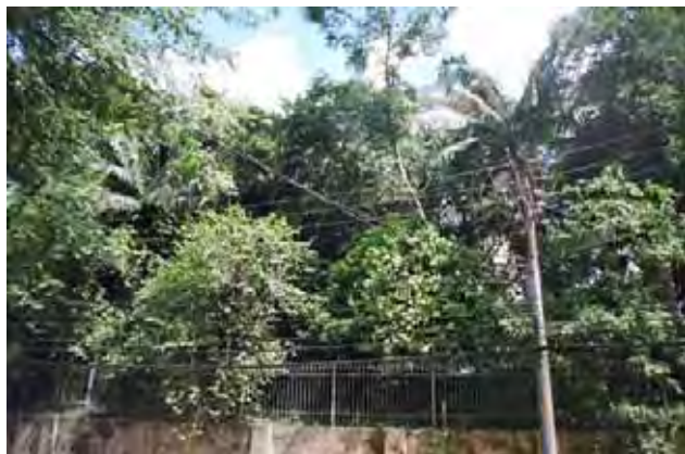
Fig. 69. Torre de caixa d' água coberta pela vegetação no reservatório do Araçá, Av. Dr. Arnaldo esquina com Av. Alfonso Bovero.
