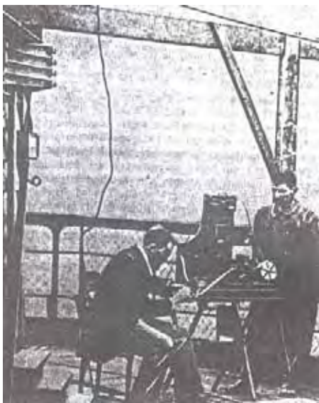
Figura 23. Testes de rádio-transmissão na torre Eiffel, em 1898.
