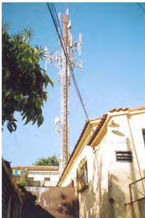
Fig. 70. Torre de telefonia celular, próxima da Av. Dr. Arnaldo.
