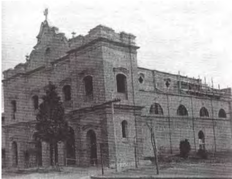
Figura 5. Construção da Igreja Nossa Senhora de Fátima.
