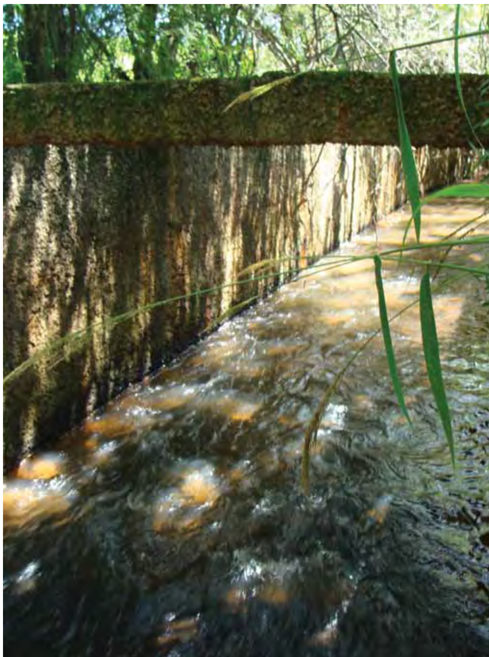
Figura 18 – Alfunte do córrego Espreado canalizado, município de Óleo. Foto obtida na coordenada E 669989.0000 / N 7462171.0000 (UTM-22, Sul).
