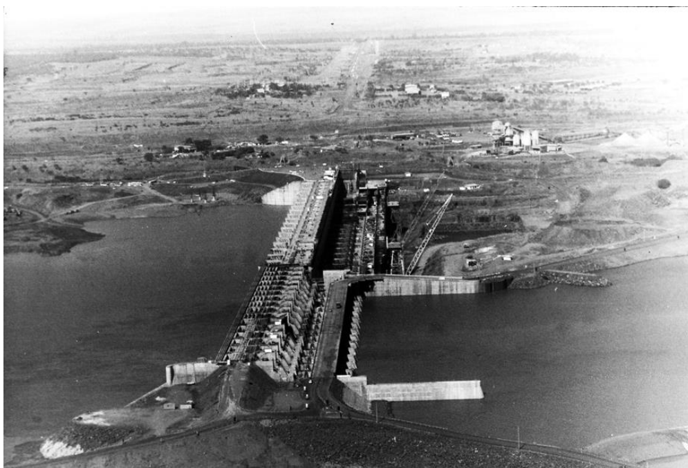
Figura 9 – Vista geral da construção da UHE Sérgio Motta.
