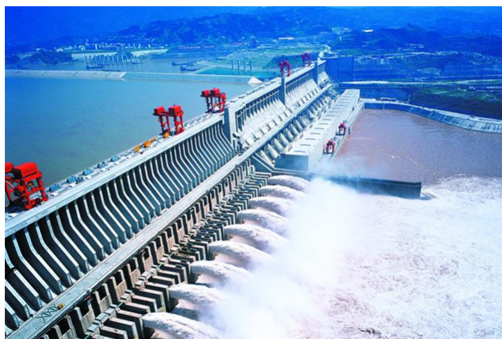
Figura 1 – Usina hidrelétrica de Três Gargantas.
