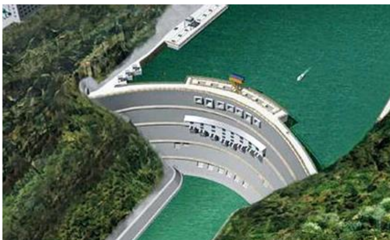
Figura 3 – Usina hidrelétrica de Xiluodu.
