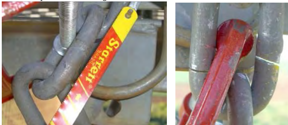
Figura A.31 – Detalhe da corrente, serra, sargento e corte
