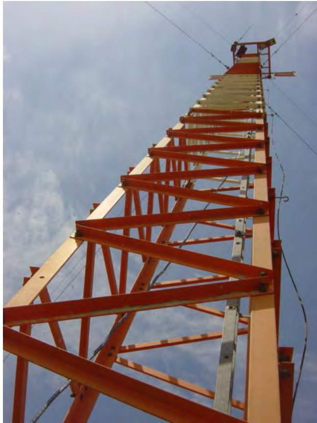
Figura A.3 – Torre metálica estaiada do farol (20°20'98S 51°18'.07W)
