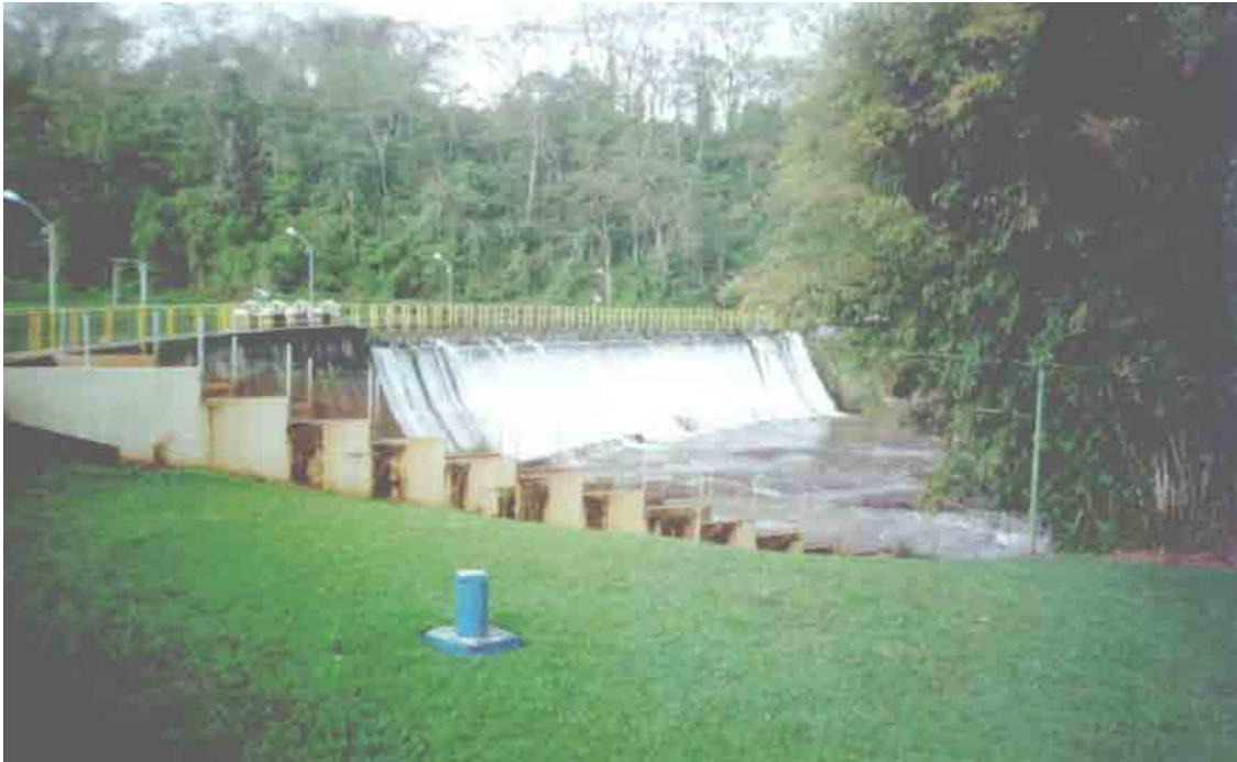
Figura 04 - Vista parcial externa da UHE Gavião Peixoto -Barragem e vertedouro
