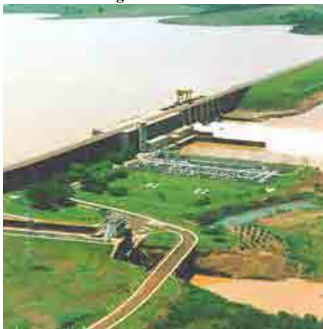
Figura 6 – Vista Externa da UHE Ibitinga – Barragem e vertedouro
