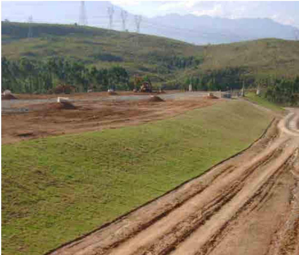
Figura 7 - Recobrimento dos resíduos sólidos e plantio de grama no talude (Fonte: Autor)
