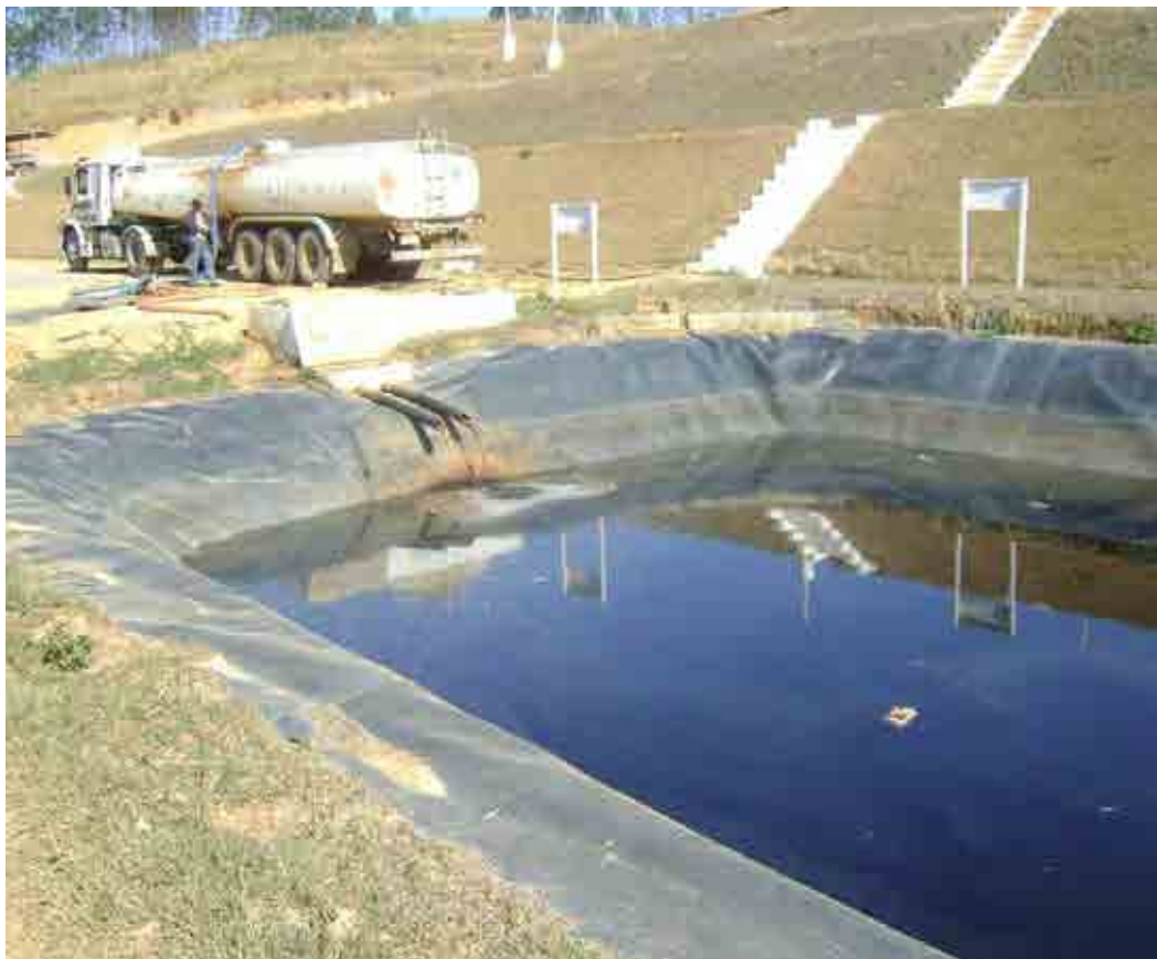
Figura 11 - Armazenamento do líquido percolado (Fonte: Autor)
