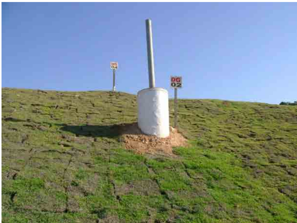
Figura 9 - Captação dos efluentes (Fonte: Autor)
