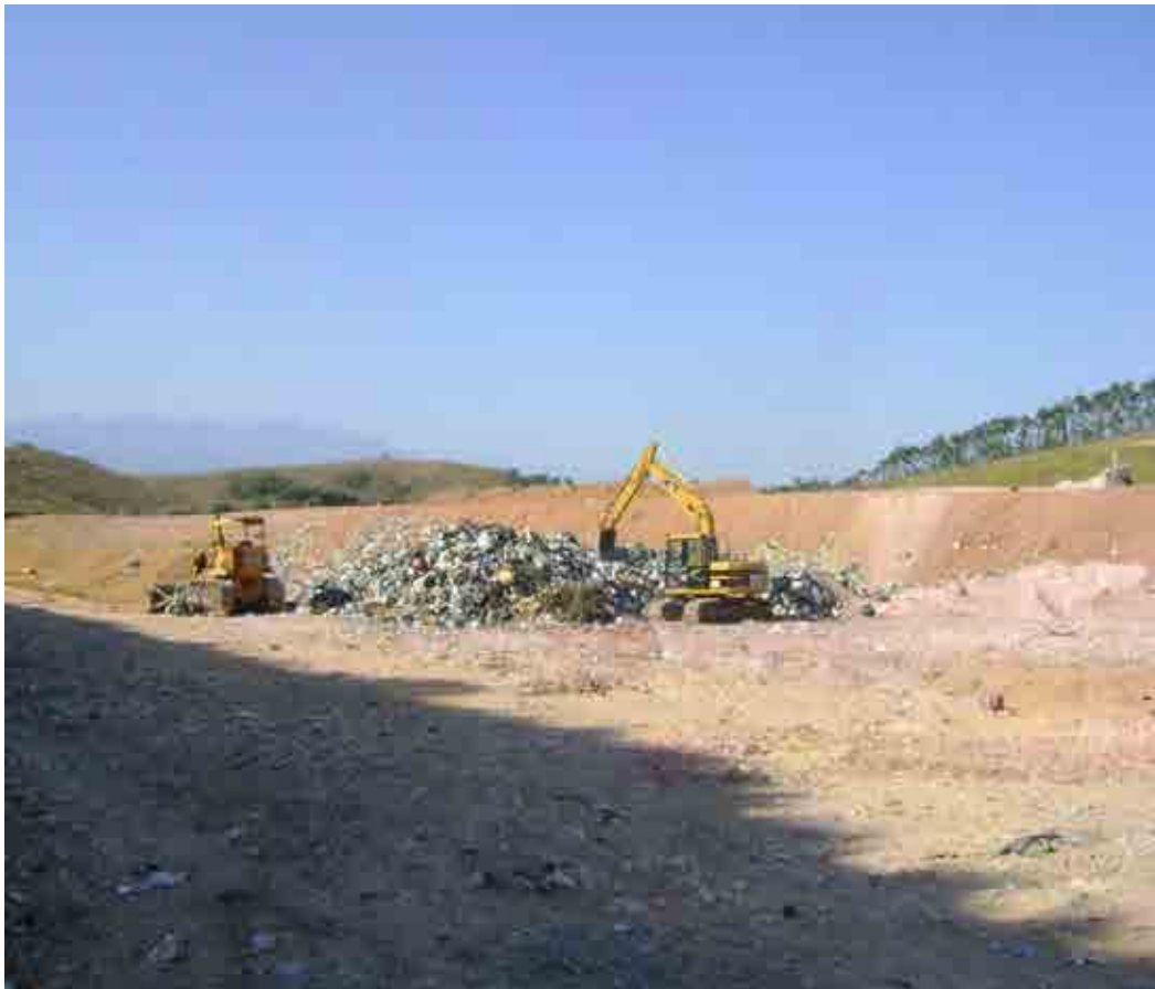
Figura 6 - Espalhamento e compactação dos resíduos (Fonte: Autor)
