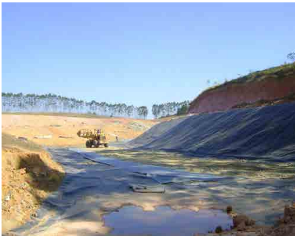
Figura 12 - Impermeabilização do aterro sanitário de Cachoeira Paulista (Fonte: Autor)
