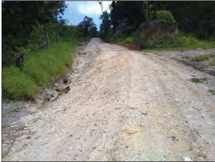
Figura 9: Trecho com rampa alta de solo composto de argila siltosa. (Fonte: Autor)
