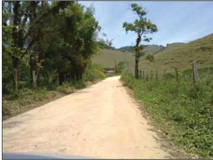
Figura 6: Foto de trecho plano composto de argila siltosa com sistema drenante funcionando na estrada Santa Cruz do Rio Abaixo. (Fonte: Autor)
