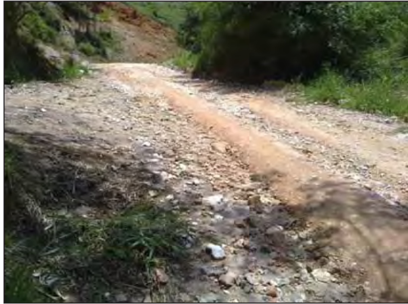
Figura 10: Trecho de rampa alta de solo composto de argila siltosa com sistema drenante não adequado para funcionamento. (Fonte: Autor)
