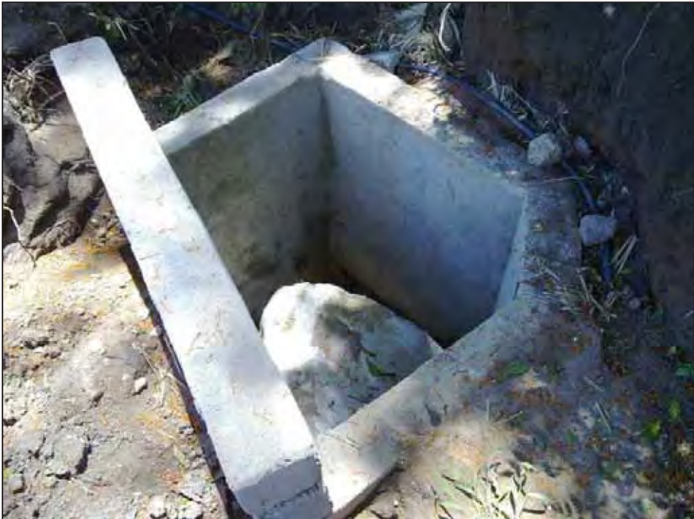
Figura 23: Obra de melhoria no sistema de drenagem. (Fonte: Autor)
