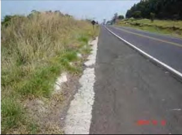
Foto 2.1 – Trincas no acostamento da rodovia causadas pelo ineficiente sistema de drenagem.
