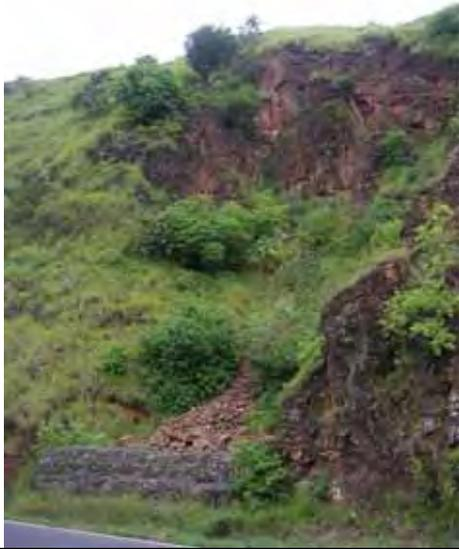
Foto 28.1 – Talude de corte da rodovia onde é visível a antiga cicatriz de escorregamento e a continuidade do processo por queda de blocos. Muro de espera em gabião ineficiente por estar completamente preenchido por blocos de rocha.
