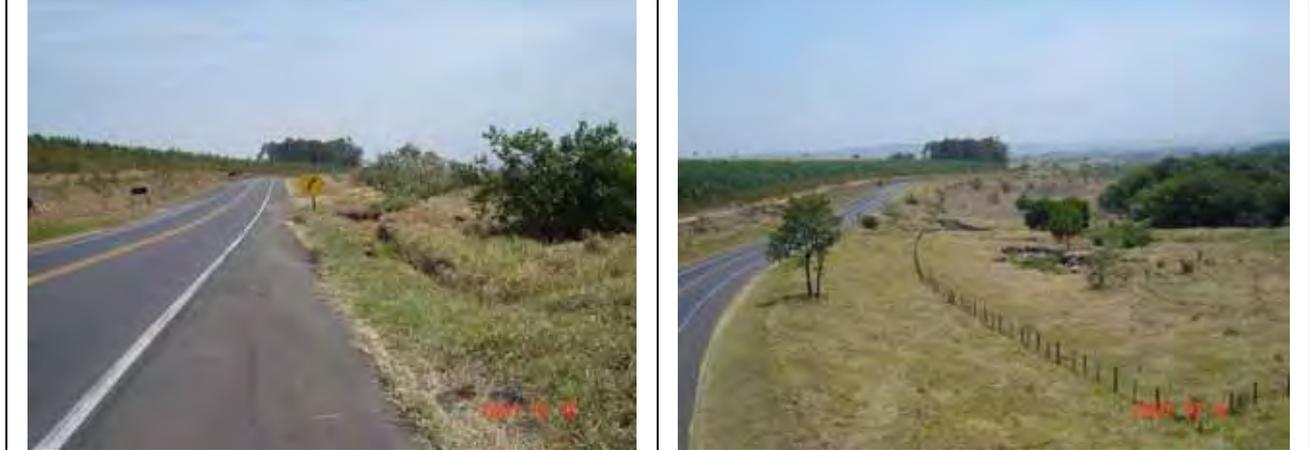
Foto 4.1 – Rodovia SP-300. Notar ramo da erosão à direita e trinca no acostamento.
