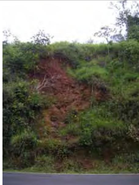
Foto 23.1 – Talude de corte da rodovia onde são visíveis as cicatrizes de movimentação à montante e as árvores inclinadas no talude, o que evidencia a movimentação por rastejo.
