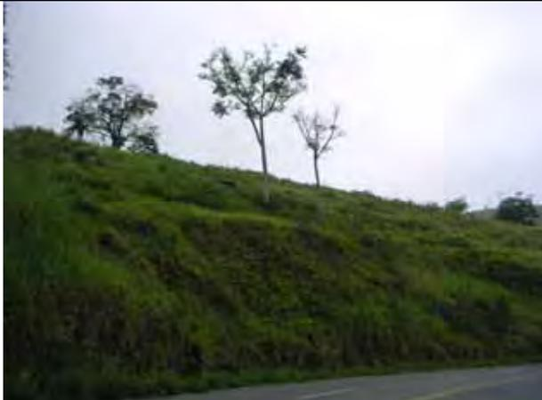
Foto 26.1 – Talude de corte da rodovia onde é visível os abatimentos no terreno à montante e as árvores inclinadas no talude, o que evidencia a movimentação por rastejo.
