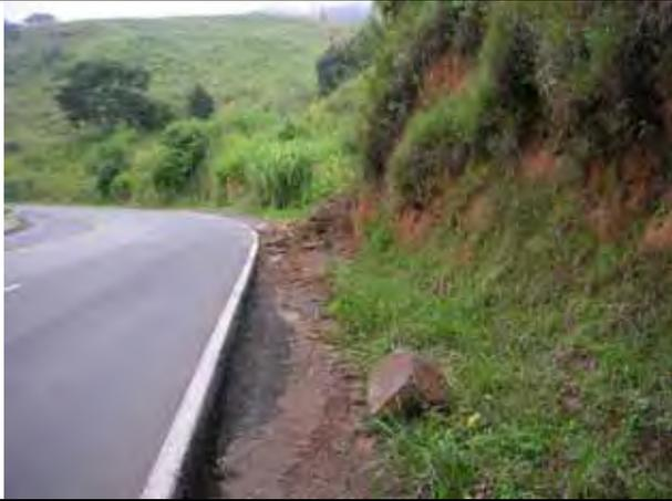
Foto 24.1 – Vista lateral do material proveniente do escorregamento gerando queda de blocos de grandes dimensões.
