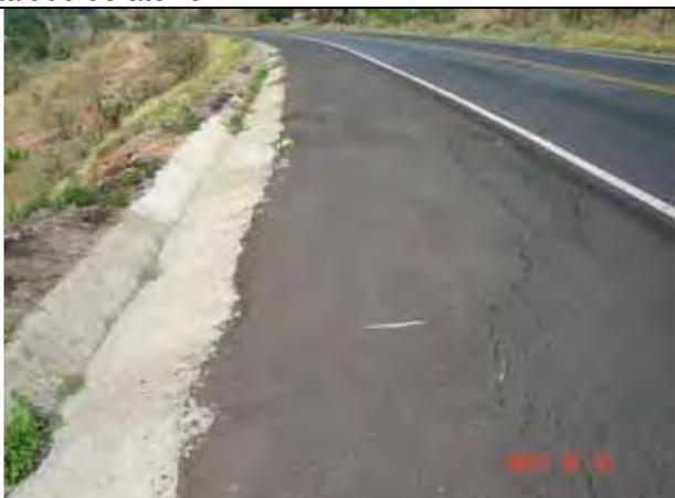
Foto 10.3 – Trincas no acostamento causadas pelo sistema de drenagem ineficiente da rodovia.
