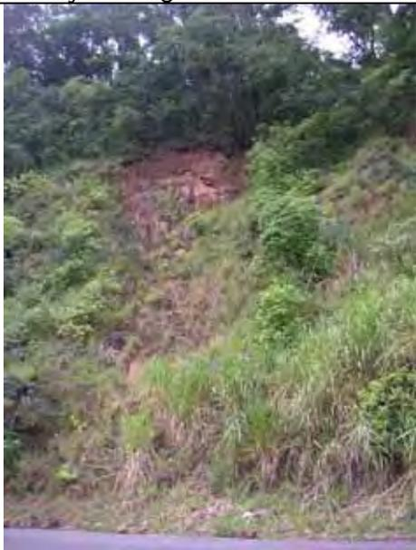
Foto 21.1 – Cicatriz de escorregamento em talude de corte da rodovia em contato entre o arenito e o basalto coberto por material de tálus.
