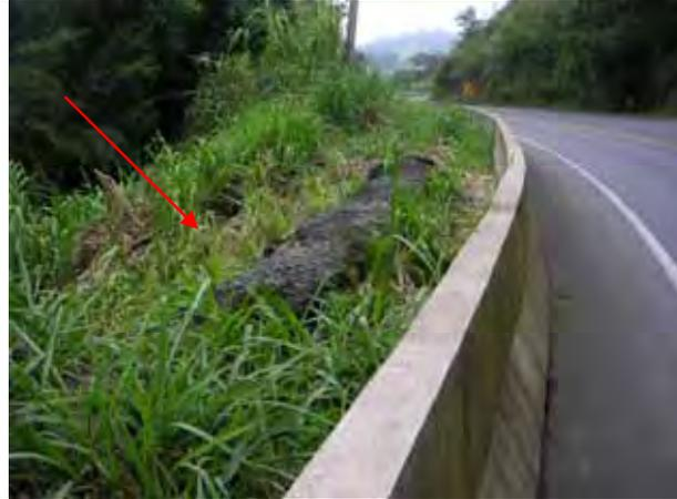
Foto 20.2 – Feição erosiva a jusante da rodovia provavelmente causada por antiga cicatriz de escorregamento.
