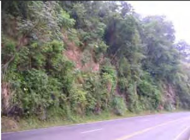
Foto 22.1 – Talude de corte da rodovia em basalto com potencial para queda de blocos.
