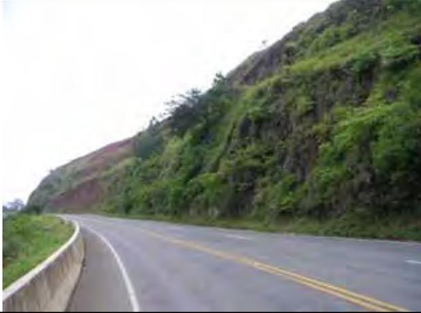
Foto 29.1 – Talude de corte da rodovia em rocha com a possibilidade de queda de blocos.
