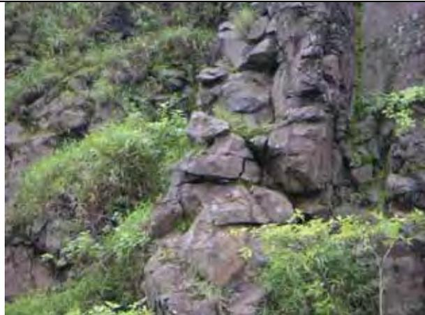
Foto 29.4 – Talude de corte da rodovia em rocha de basalto com queda de blocos.
