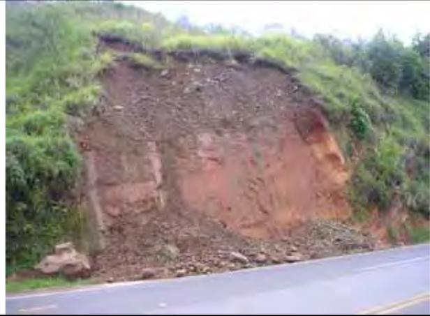
Foto 24.2 – Vista frontal do escorregamento mostrando o contato entre o arenito e o depósito de tálus. Atentar para o tamanho dos blocos de rocha.
