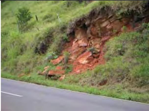
Foto 27.1 – Talude de corte da rodovia em arenito com potencial para queda de blocos.
