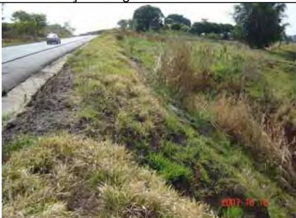
Foto 10.1 – Vista lateral do processo erosivo no talude do aterro.
