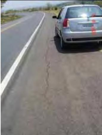
Foto 6.3 – Trinca no acostamento.
