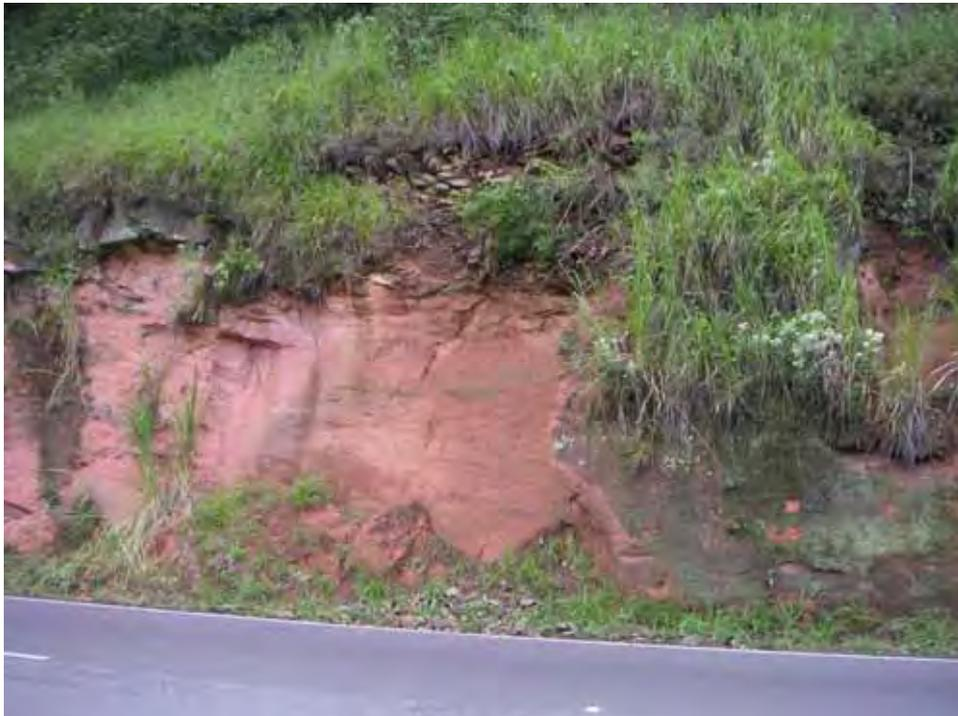
**Foto 1.** Depósito de tálus cobrindo a rocha no talude de corte da rodovia.
