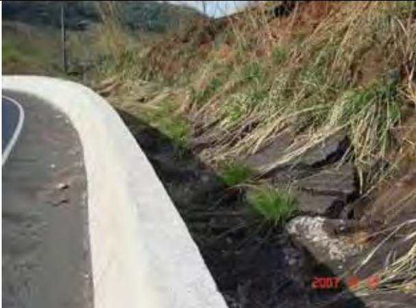
14.3 – Restos de asfalto no sistema de drenagem da rodovia.
