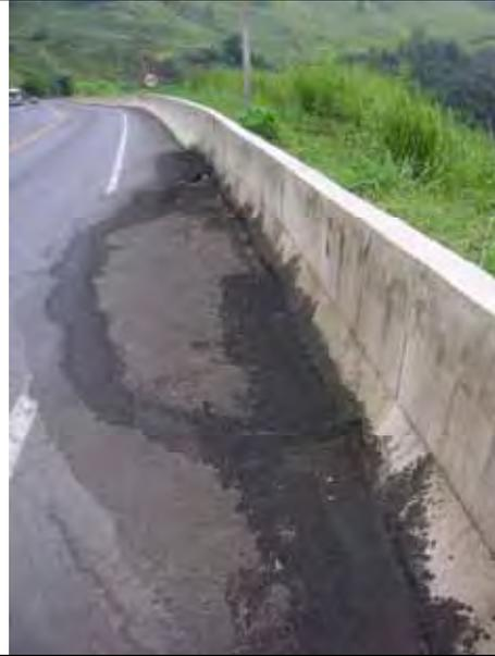
Foto 25.1 – Abatimento na pista causado por ineficiência do sistema de drenagem, com degrau de aproximadamente 5cm, gerado por ravinamento a jusante da rodovia.
