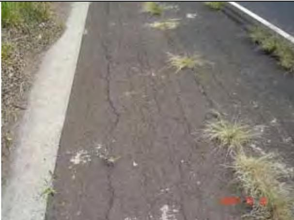
Foto 3.3 – Trincas no acostamento.
