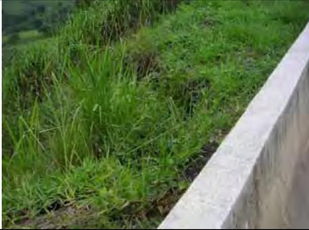
Foto 19.1 – Crista do escorregamento distando cerca de 1m da guarnição da pista.
