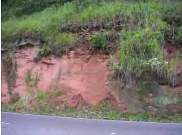
Foto 20.1 – Talude de corte da rodovia em Arenito coberto por material de tálus.
