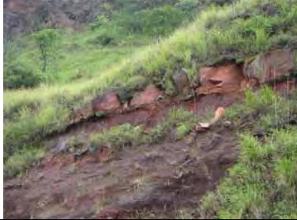
Foto 29.2 – Talude de corte da rodovia em rocha com "trap" de arenito sobre o basalto com queda de blocos.
