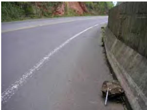
Foto 21.2 – Bloco de rocha proveniente do escorregamento atravessou a pista da rodovia.
