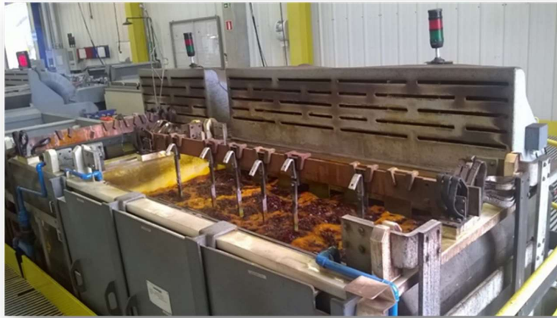
Figura 12 - Gancheiras encaixadas no barramento do tanque de anodização crômica
