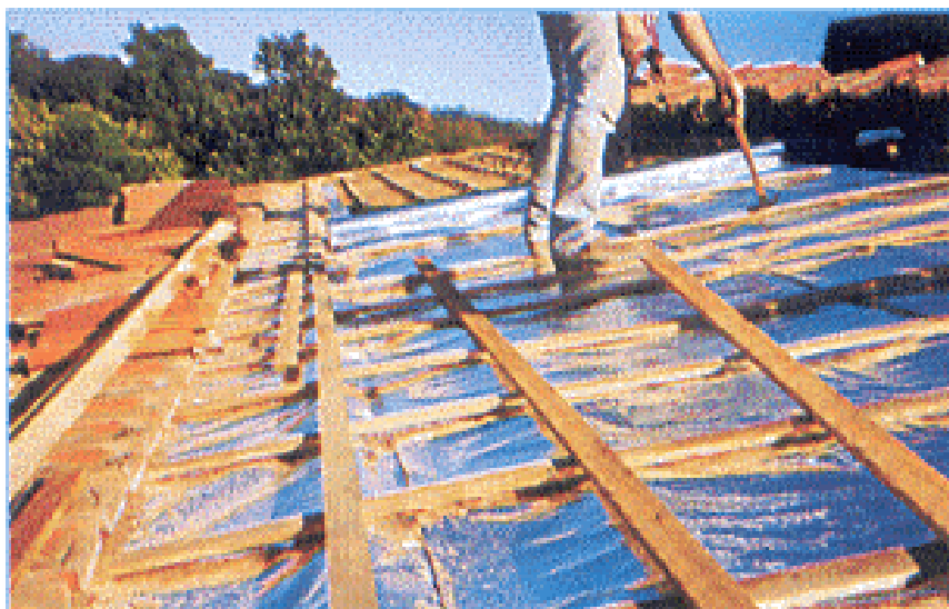
Figura 2. Telhado sendo montado com o uso de subcobertura.
