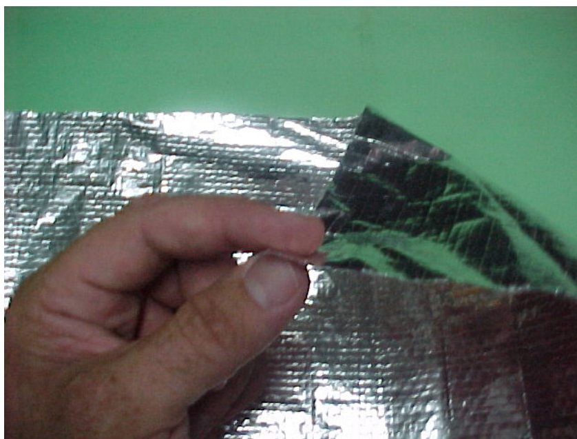
Figura 9. Detalhe da subcobertura 1.
