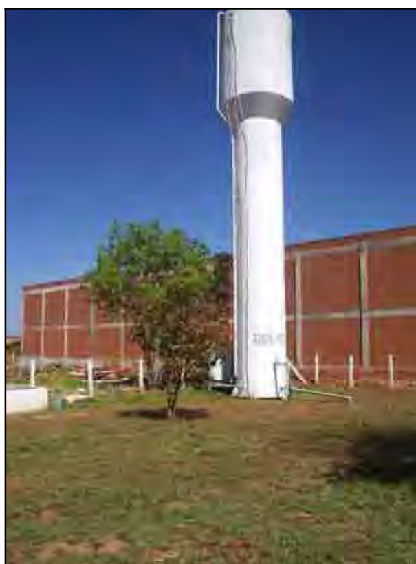
Fotografia 10. Reservatório elevado do Distrito Industrial – DAIARA
