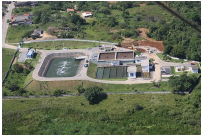
Figura 1 - Visão aérea ETE do bairro do Araretama, Pindamonhangaba/SP
