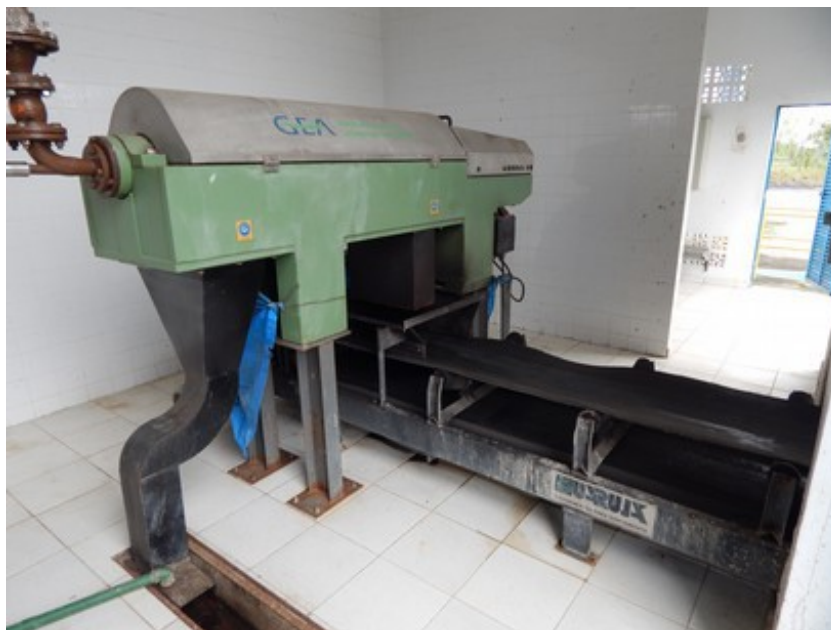
Figura 11 - Centrífuga de eixo horizontal GEA Westfalia
