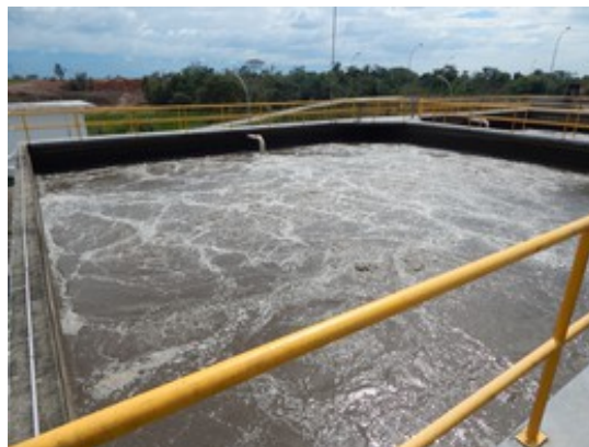
Figura 2 - Reator biológico em funcionamento
