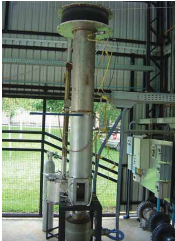
Figura 18 – Foto da câmara na primeira montagem
