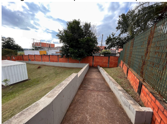
Figura 20 - Rampa de acesso a quadra
