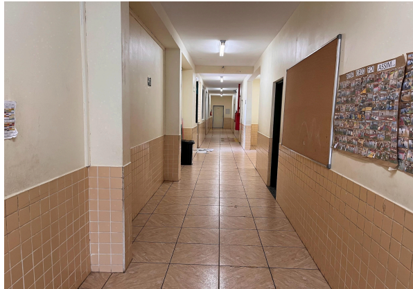
Figura 7 - Corredor de acesso à biblioteca
