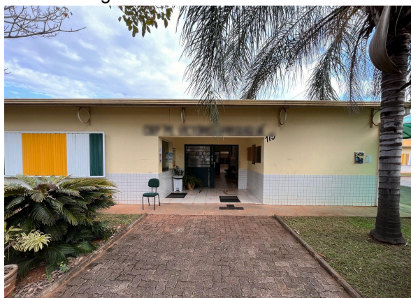
Figura 17 - Fachada da escola
