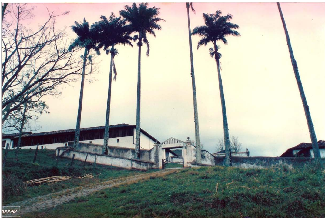
Foto 29. Fazenda Pau-D'Alho, vista da entrada (município de São José do Barreiro) Fonte: ANTONIO FILHO, F. D., 2002
