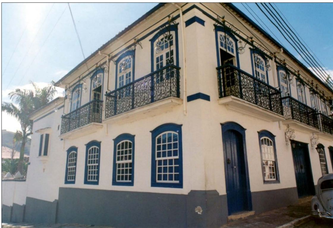
Foto 20. Sobrado da Dona Laurinha, construção de 1811 Fonte: ANTONIO FILHO, F.D. 2002
