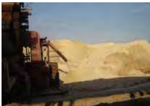
Figura 52. Vista parcial do depósito de bagaço.
