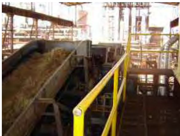
Figura 51. Esteira conduzindo bagaço para a caldeira.
