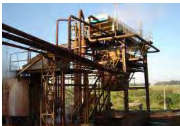
Figura 58. Vista da torre de aproveitamento de resíduos.
