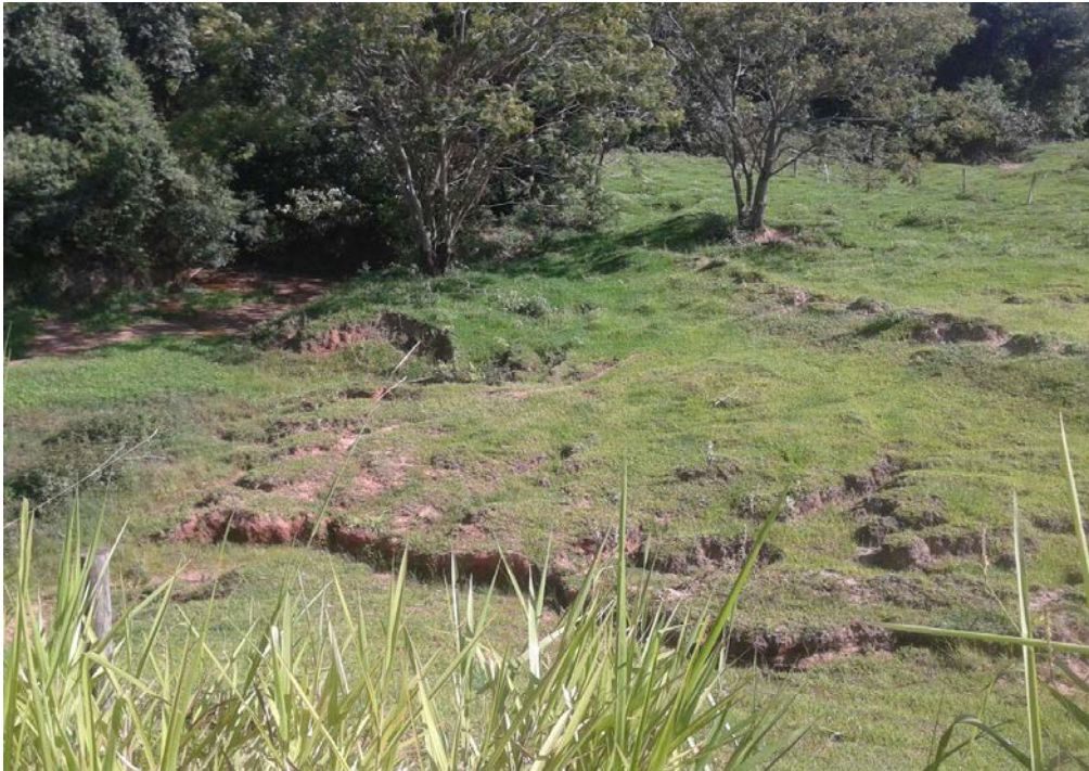
Figura 20 - Ravina identificada em campo. Porção superior (montante).
