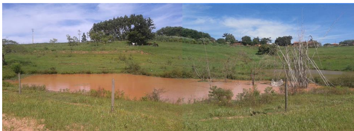
Figura 16 - Intervenção em área de ravina através de obras para o controle de escoamento superficial. Vista da porção superior (montante) da ravina.
