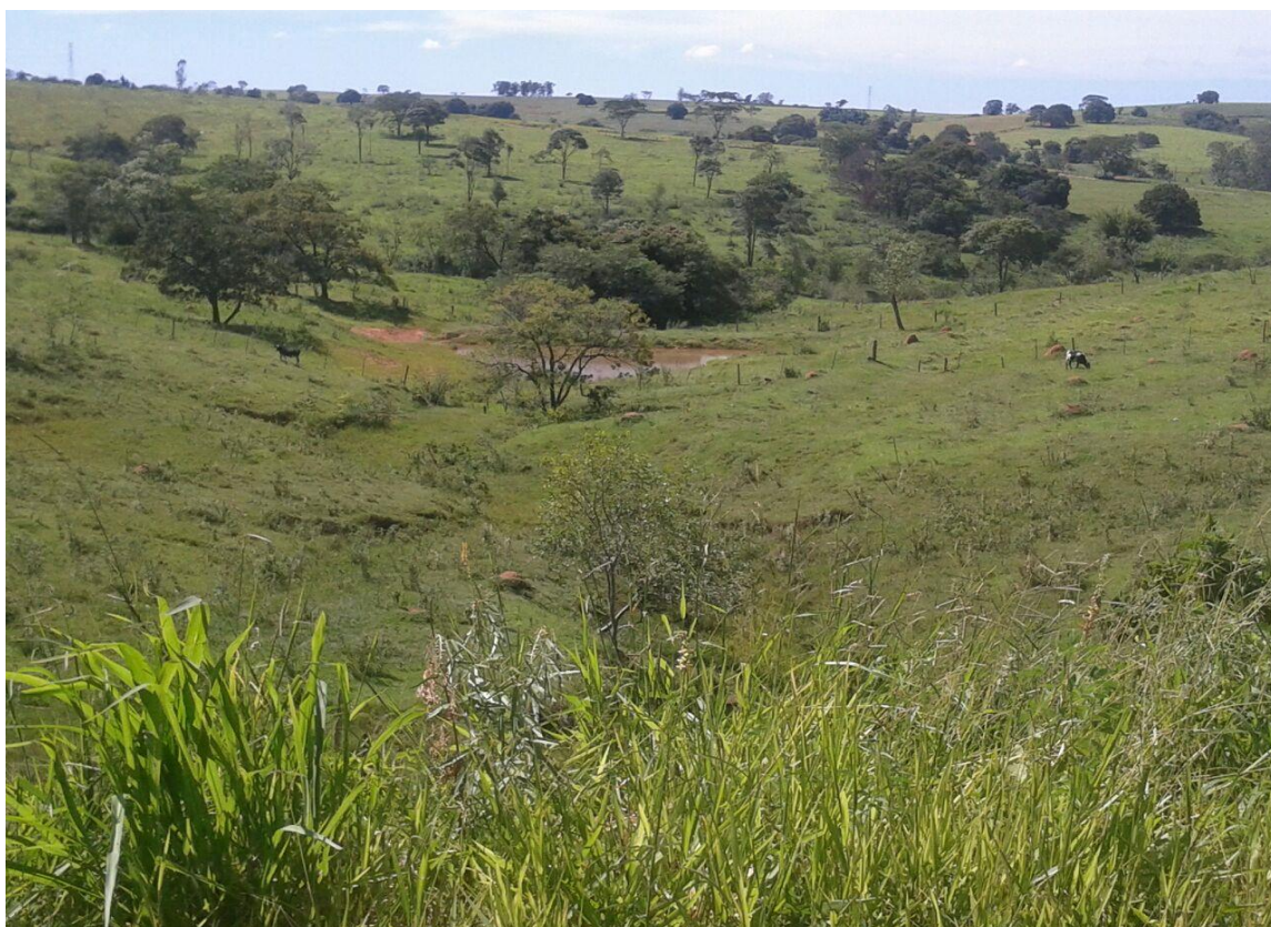
Figura 17 - Intervenção em área de ravina através de obras de drenagem. Porção inferior da ravina (jusante).
