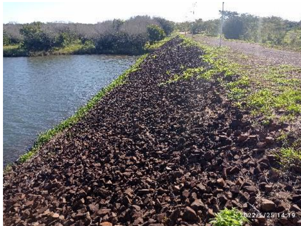
Figura 37: Talude de montante ME – vegetação crescente no enrocamento, a esquerda da TA.
