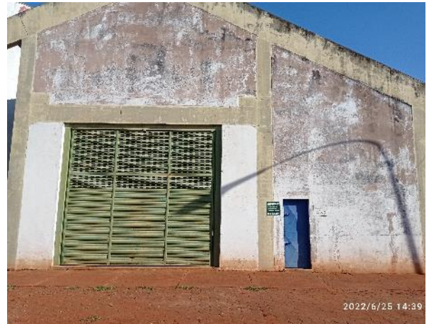
Figura 29: Casa de bombas – visão do exterior da casa de bombas.
