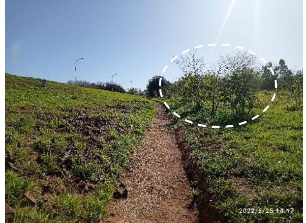
Figura 44: Talude de jusante ME – dreno de pé – canaletas de drenagem em bom estado.
