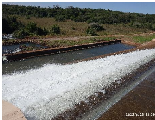
Figura 51: Bacia de dissipação – visão geral.
