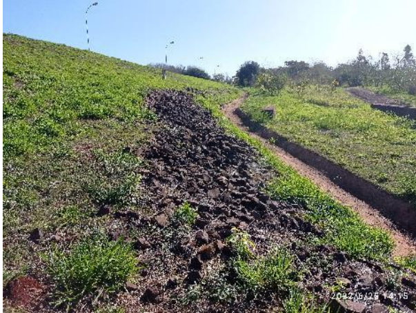
Figura 43: Talude de jusante ME – dreno de pé – dreno de pé com um pequeno crescimento e vegetação.
