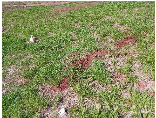
Figura 42: Talude de jusante ME – colônias de formigas, vista 2.
