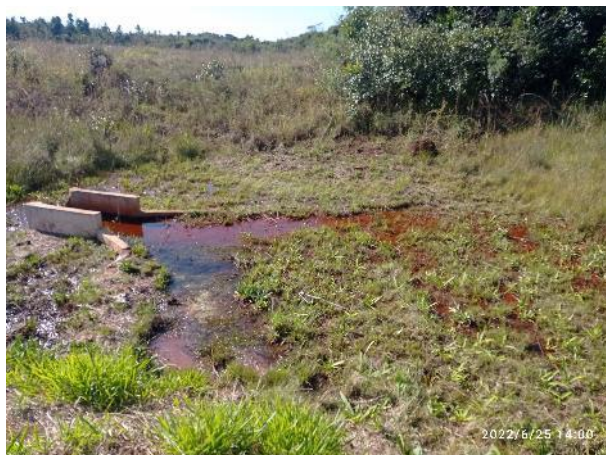
Figura 66: Instrumentação – fuga d'água para lateral do medidor de vazão devido à obstrução e aumento da vegetação.
