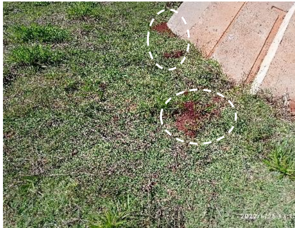
Figura 41: Talude de jusante ME – colônias de formigas, vista 1.
