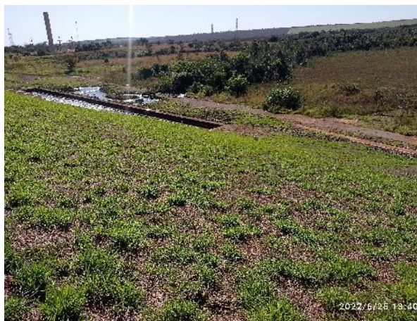
Figura 57: Talude de jusante MD – vista geral.
