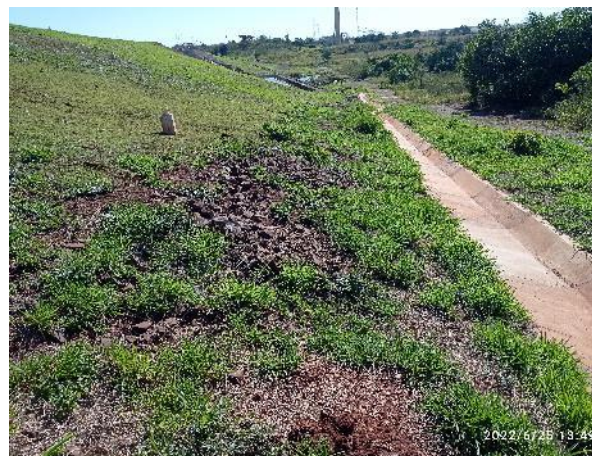
Figura 58: Talude de jusante MD – canaleta de drenagem.
