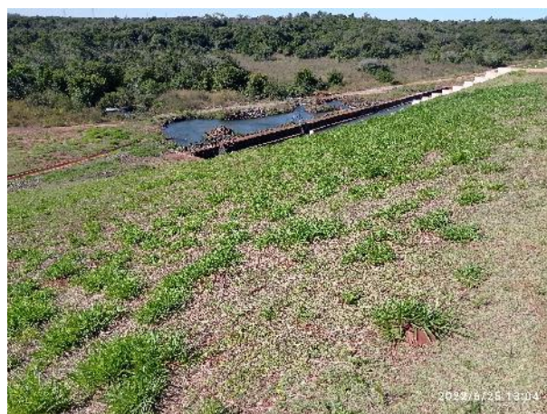
Figura 40: Talude de montante ME – visão geral, vista 2.
