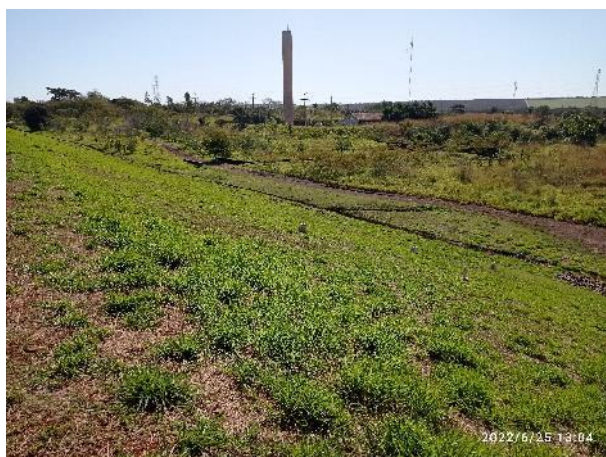
Figura 39: Talude de montante ME – visão geral, vista 1.
