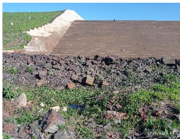
Figura 52: Bacia de dissipação – surgência observada.
