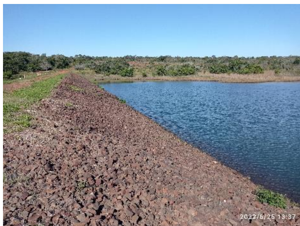
Figura 56: Talude de montante MD – vista geral.
