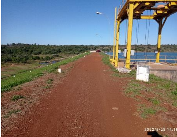
Figura 45: Tomada d'água – vista lateral.
