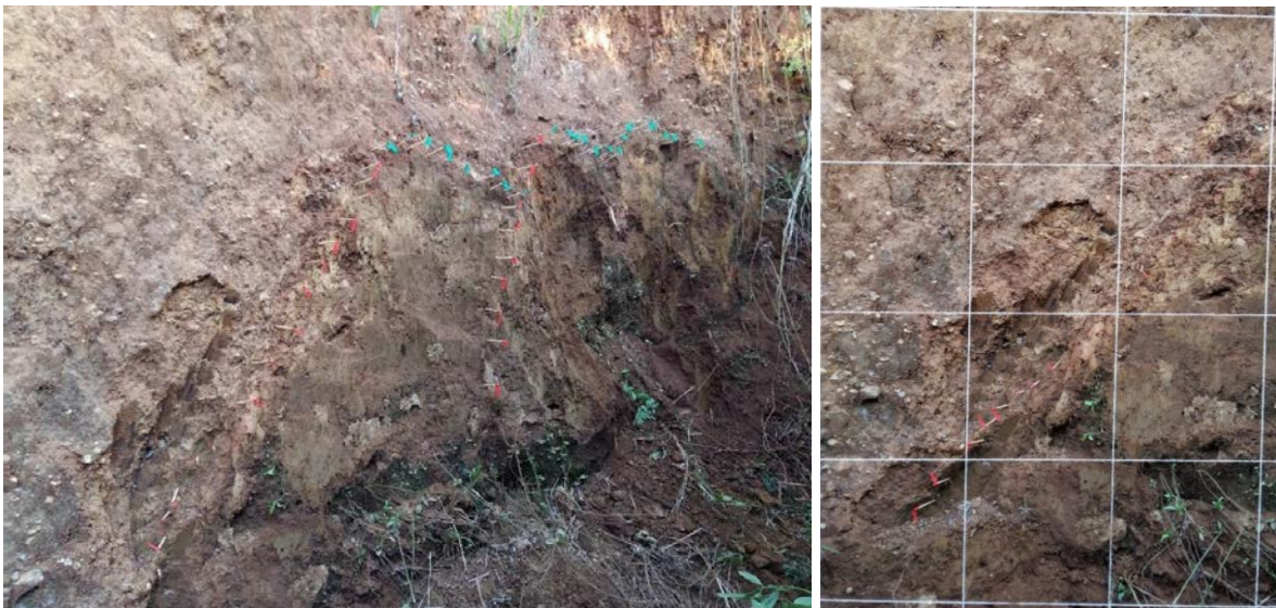
Figuras 5.22 e 5.23 – Afloramento de diabásio falhado com marcações de bandeiras para a aquisição do “ pseudotrenching ”.
