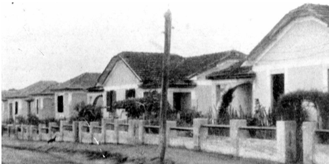
Figura 15: Habitações operárias na Vila Nitro Operária em São Miguel pta. Fonte: acervo particular Felipe Godoy
